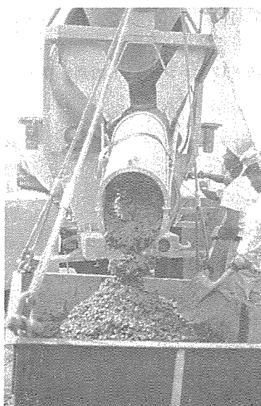
写真-1 コンクリート排出状態
