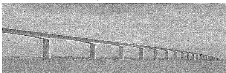
写真-1.4 Oleron 高架橋 Span 9 @ 39.5 + 59.2 + 26 @ 79.0 + 59.2 + 7 @ 39.5
