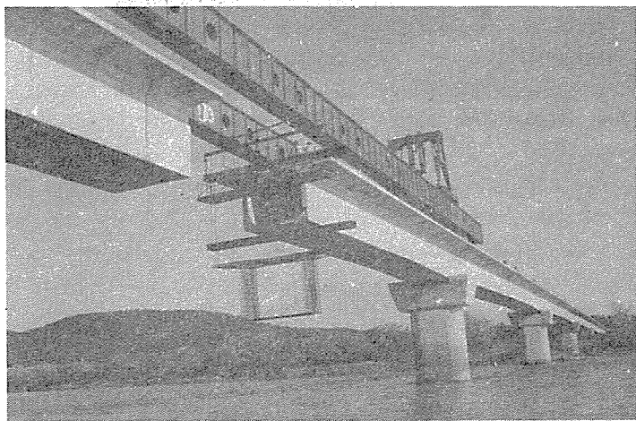
写真-1.14 国見橋 Span 9@59.5
