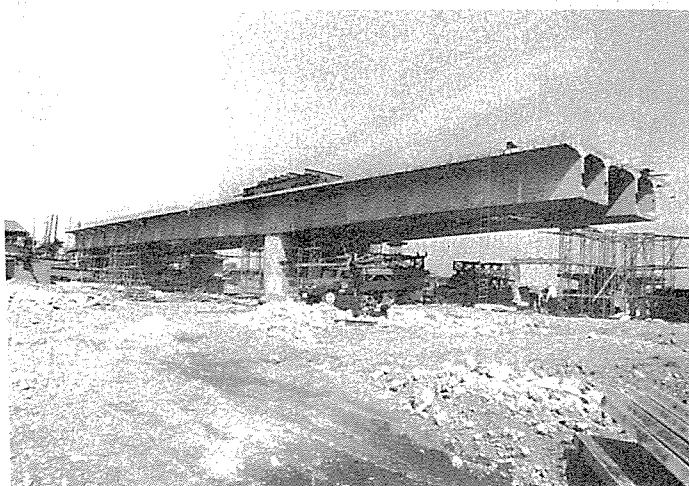
写真－1.9 多摩橋 Span 50+2@50+50
