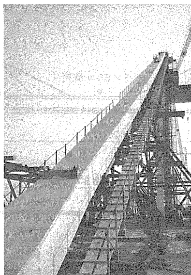
図-9 PC吊ケーブル用支保工 プレキャスト部材を配列
