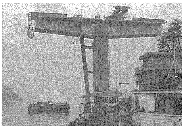
写真－1.10 神島大橋 Span 41+86+41 m
