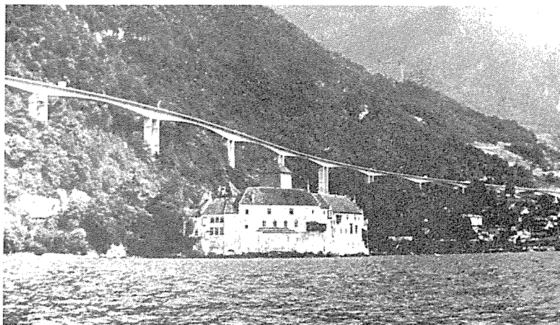
写真-1.6 Chillon 高架橋 Span 45.4 + 10. @ 92.0 + 6 @ 98 + 5 @ 104 + 45.5 m
