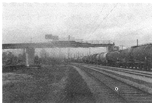
写真－3 鉄道上の架設
