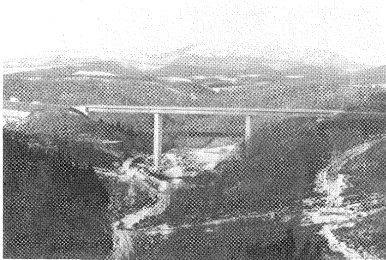
写真-22 完成した幌萌大橋
