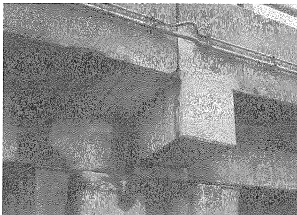
写真-5 片持床版の横げたによる補修
