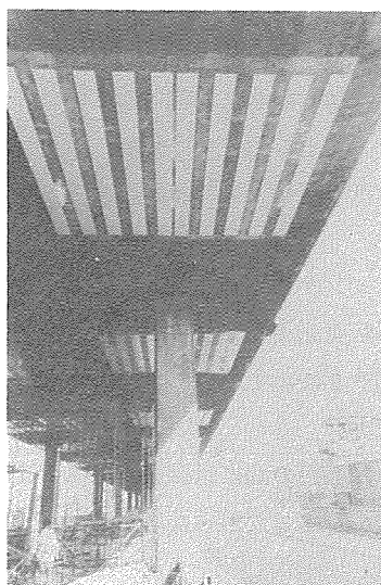
写真-3 鋼板による桁の補修完成
