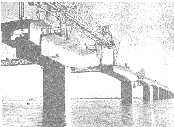
写真－５ Oléron 高架橋
