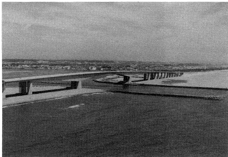
写真－1.6 桁完成後の浜名大橋（施工中写真は第5章参照）
