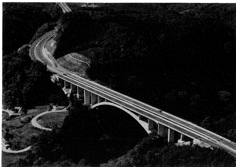
写真－1.9 ピロン・メラン併用工法で完成した帝釈橋 （施工中写真は第5章参章）
