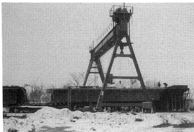
写真-5.3.3 ブロックの製作例
