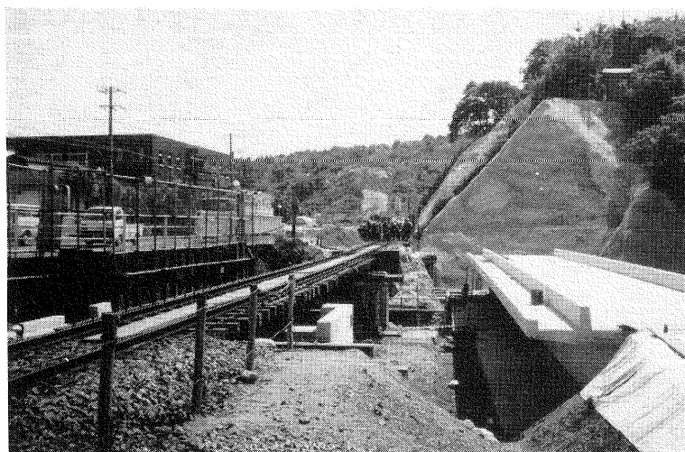
写真－３－１－２ 架設前(鯉川橋りょう)
