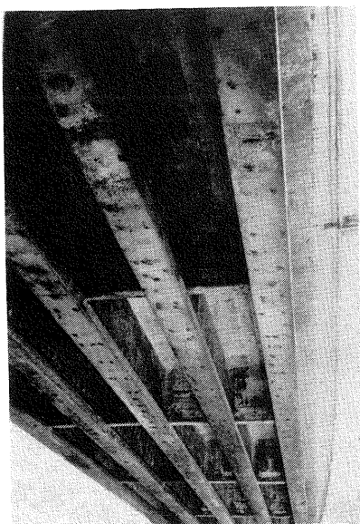
写真-1 コンクリート橋の表面に現われた錆
