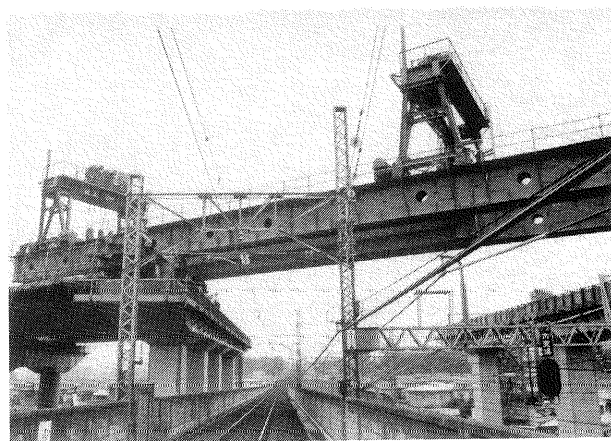
写真-4 武蔵野線 B; (桁架設中)
