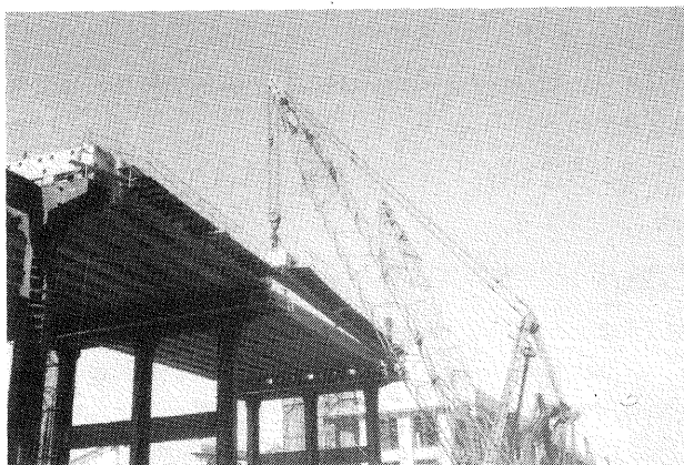
写真-8 H形鋼の橋脚と桁架設 (1)
