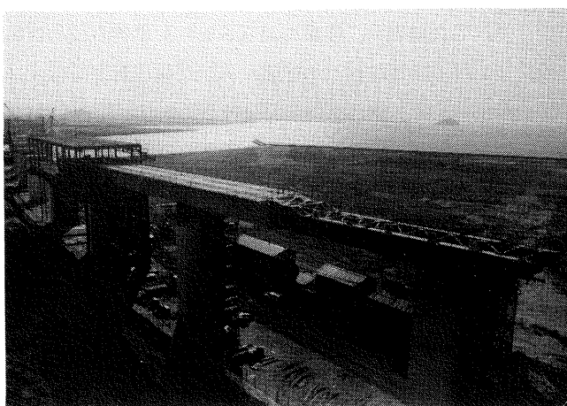
写真-16 番の州鉄道高架橋の施工状況
