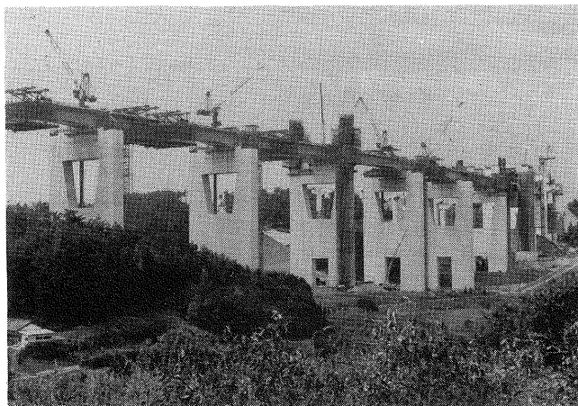
写真-8 与島高架橋鉄道桁の施工
