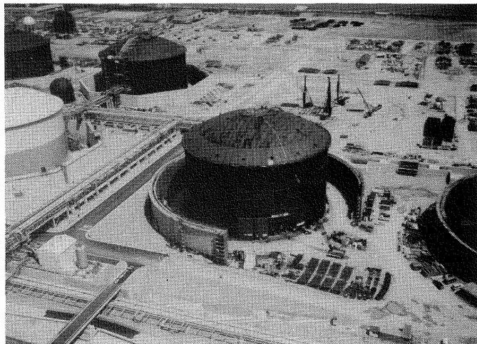
写真－4.1 PC 防液堤の近景
