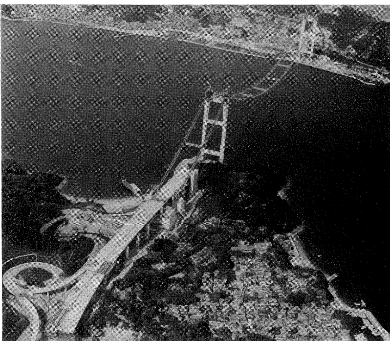
写真－1 海峡部の工事状況（㈱計測リサーチ提供）
