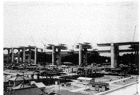
写真－2.33 櫃石島高架橋(張出し式架設)
