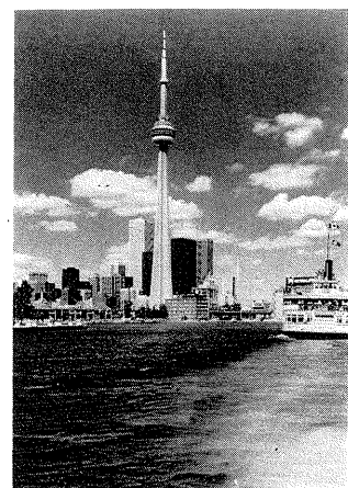
写真一 4.14 CNタワー (完成)
