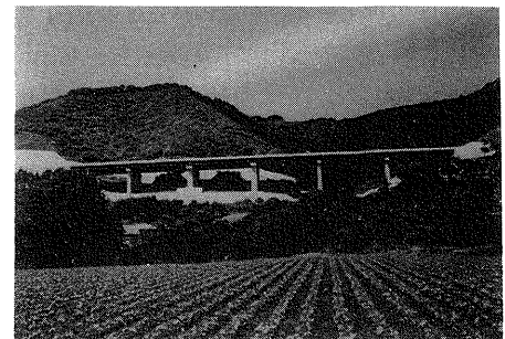
写真－2.12 榑山第二橋（完成）
