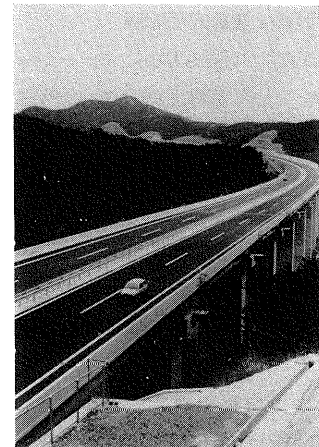
写真－2.10 佐方第一橋（完成）
