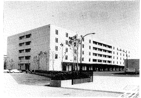
写真一 4.4 東京・関東郵政局資材倉庫（完成）
