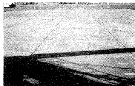
写真—5.4 東京港埠頭PC舗装（完成）
