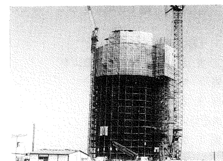
写真— 3.5 田舎館村高架水槽（施工中）
