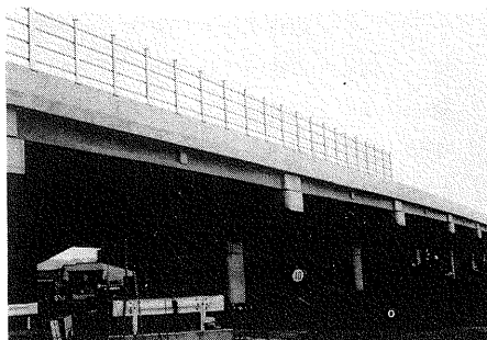
写真—2.8 西田高架橋（完成）
