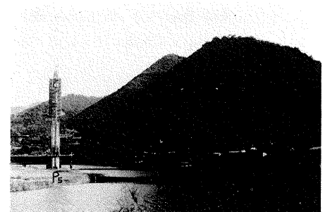
写真— 2.23 新丹波大橋（施工中）
