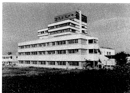
写真－4.2 埼玉協同病院（完成）
