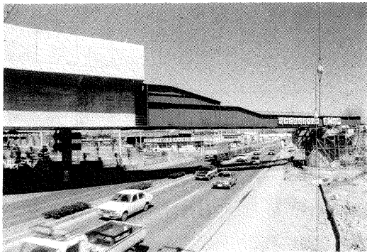
写真-3 押し施工全景
