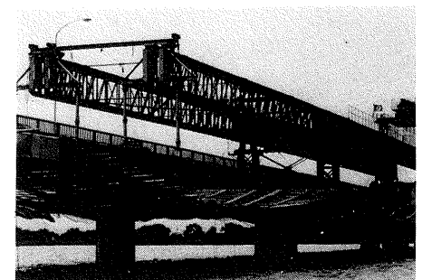
写真-2.4 近江大橋（エレクションガーダーによる架設）
