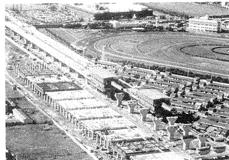
写真— 2.53 若松高架橋 (施工中)
