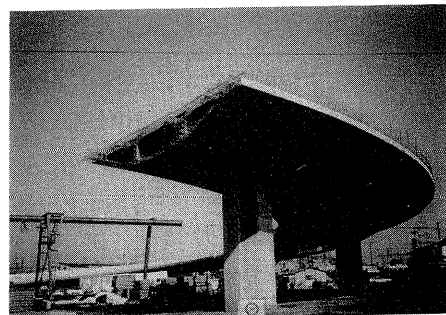
写真－2.28 野田川ループ橋（施工中）
