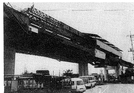
写真— 2.55 浮塚高架橋（施工中）
