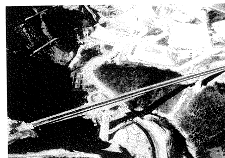
写真－2.38 阿木川ダム2号橋（完成）
