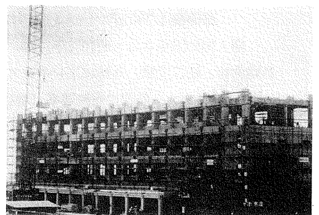
写真一 4.7 東海産業短期大学（施工中）
