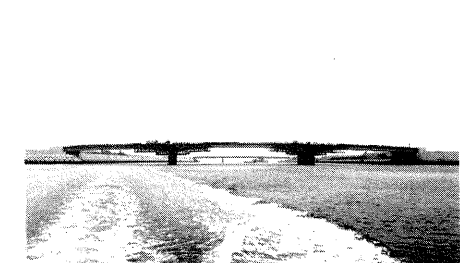
写真— 2.17 二色の浜連絡橋（施工中）
