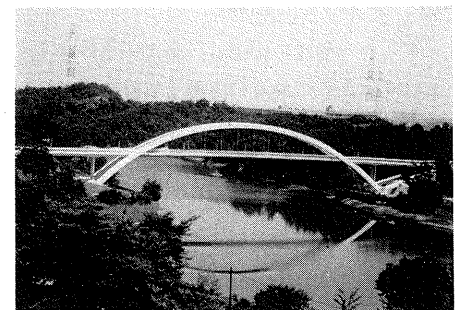
写真— 2.21 光明池大橋 (完成)
