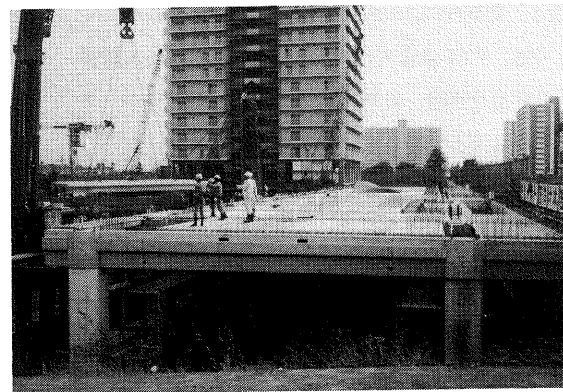
写真－6.3 FTTスラブの架設状況
