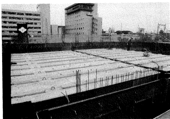
写真一 3.1 敷設状況
