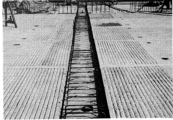
写真－6.2 打継部粗面仕上げの状況 (端部1.0mまでV目地)
