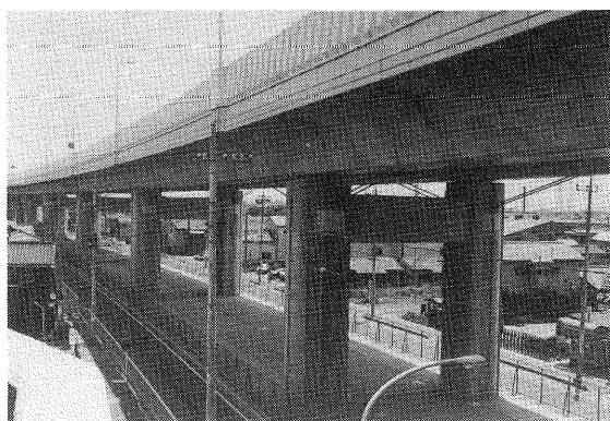
写真-10 浮塚高架橋
