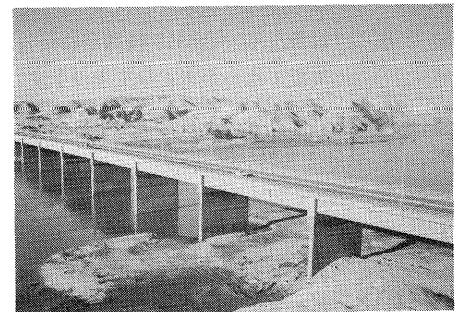
写真-2.7 ファタ橋
