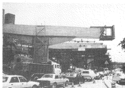
写真－2.4 マクリッチ高架橋
