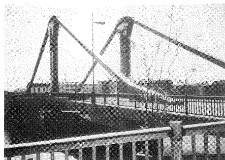
写真— 2.54 フレーザー橋
