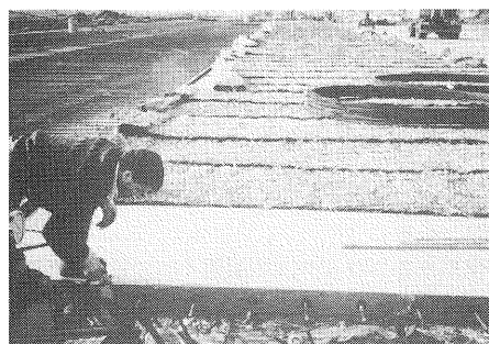
写真—5.1 スキポール空港エプロンPC舗装
