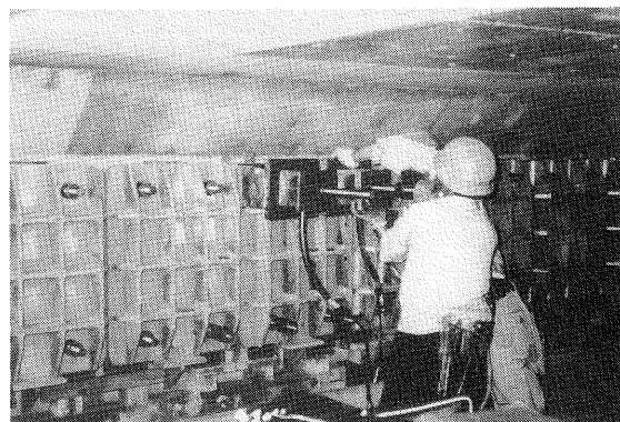
写真-17 薄根川橋桁端部
