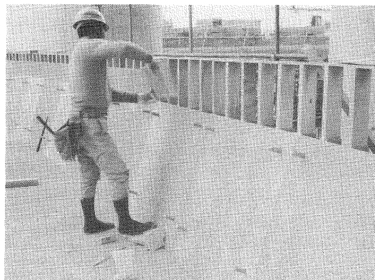
写真-10 防食パネル施工
