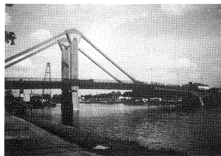
写真— 2.55 フレーザー橋
