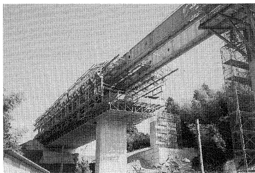
写真-5 大型移動支保工
