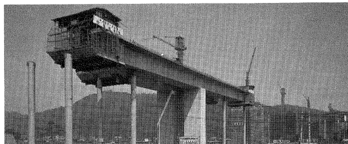
写真一10 ベントをたて張出し中の川音川橋
