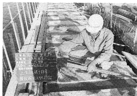
写真一7.6 無収縮モルタル打設完了
