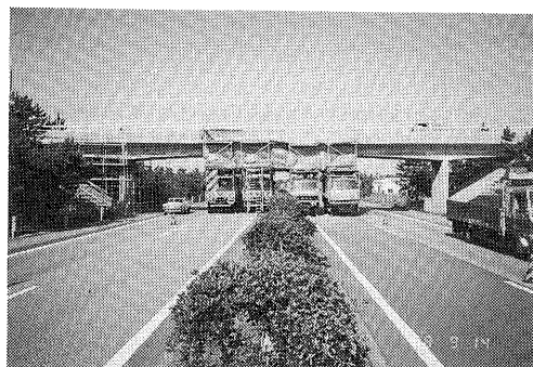
写真-6.3 オーバブリッジの塩害補修のための移動足場
