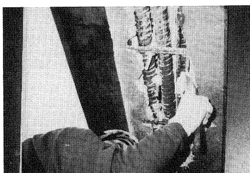
写真-2.6 補修用樹脂の塗布状況
