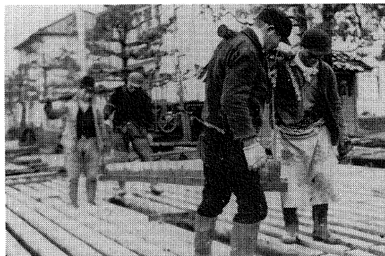
写真一 人力で桁を運搬中の長生橋
