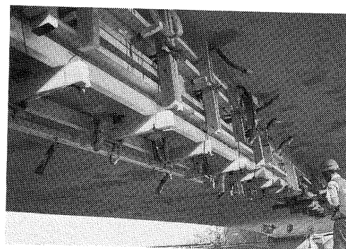
写真-6.5 吊り型枠の設置（断面修復用型枠で夜間は桁下通行となる。）
