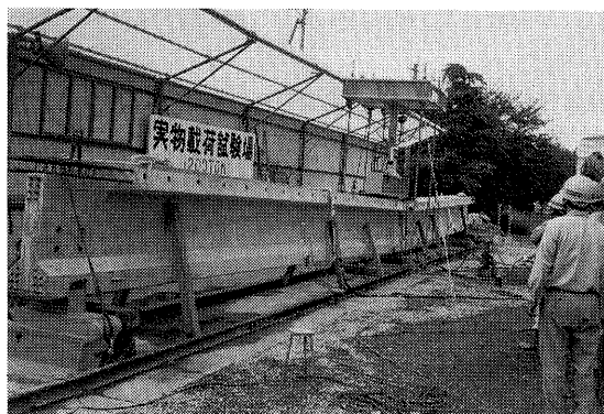
写真-3 破壊直後の桁全景
