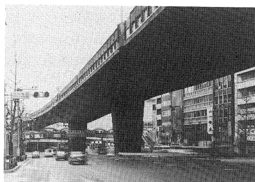
写真-9.4 都心側南面(現況)
