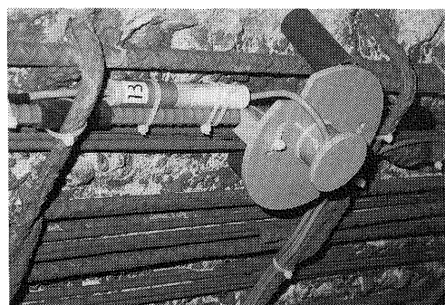
写真－6.11 鋼材腐食の経時変化を測定するためのモニタリング用プローブ
