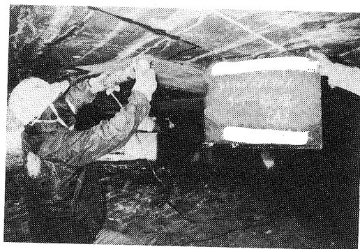
写真一 1.3 下フランジ下面サンダー処理
