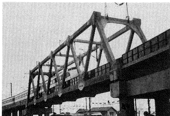
写真-3 岩鼻PCトラス橋
