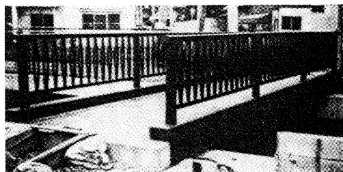
写真-2 CFRPを用いたPC人道橋
