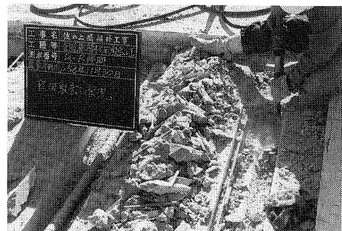
写真一7.5 PC鋼材取り出し
