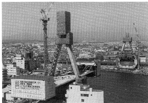
写真－3.11 主塔を立上げながら張出中の青森ベイブリッジ
