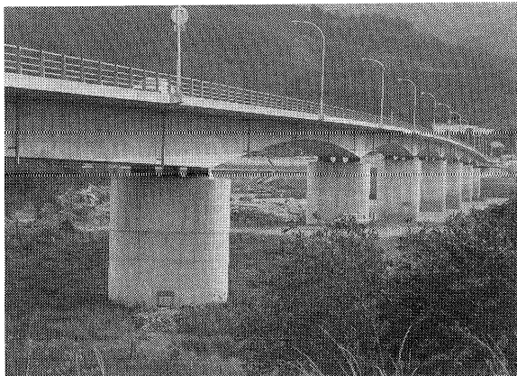
写真一七 美馬中央橋（徳島県，竣工：1988年）
