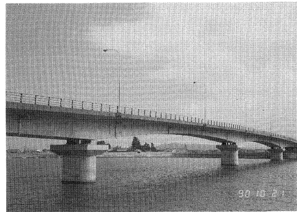
写真一十 新中山川大橋（愛媛県，竣工：1978年）
