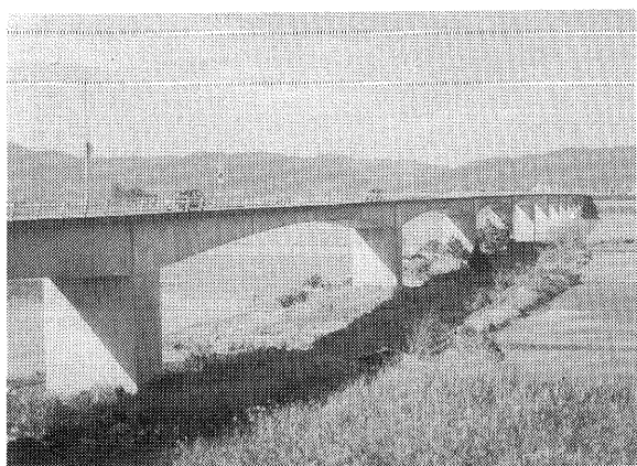
写真一22 名田橋(徳島県、竣工:1963年)
