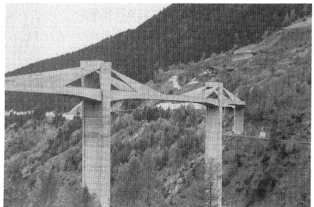
写真- 3.10 完成した Ganter 橋
