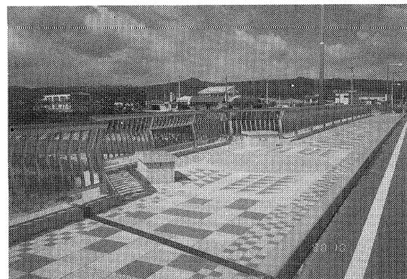
写真-25 新土岐川橋
