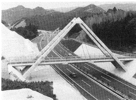
写真-32 日根野跨道橋（大阪府，竣工：1989年）
