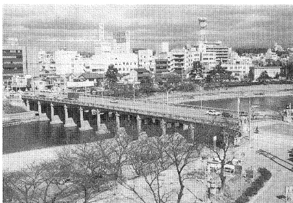
写真－1 殿橋改修前
