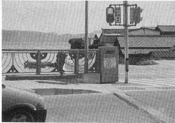
写真一 2 オリーブ大橋(香川県, 竣工:1970年, 改修:1987年)
