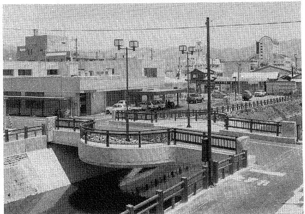
写真一1 椿橋（高知県，竣工：1987年）
