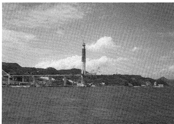
写真- 3.6 側径間コンクリート桁の架設が終了した生口橋
