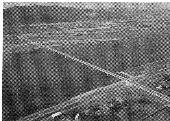
写真－15 立田大橋
