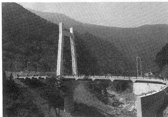
写真一27 端出場大橋(仮称) (愛媛県, 竣工: 1990年)
