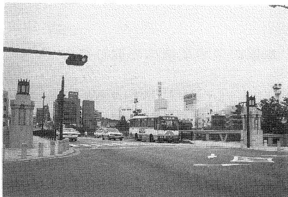
写真－2 殿橋改修後
