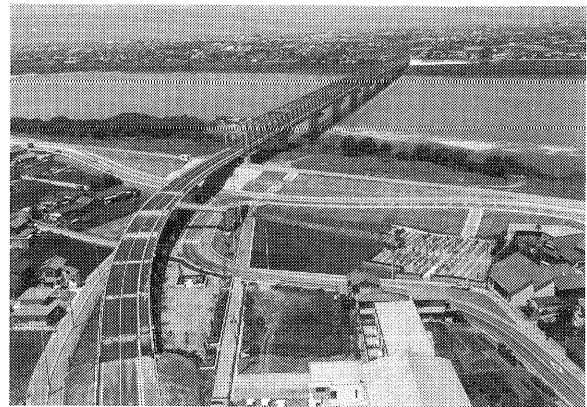
写真－14 尾濃大橋
