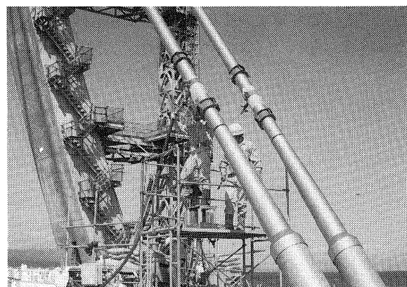
写真 9 斜材グラウト
