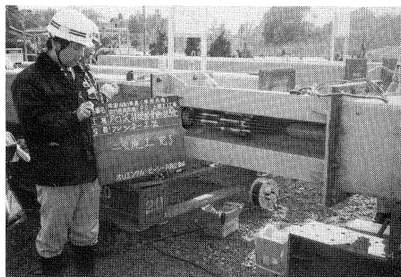
写真-1 施工継目のP C定着具の挙動確認試験
