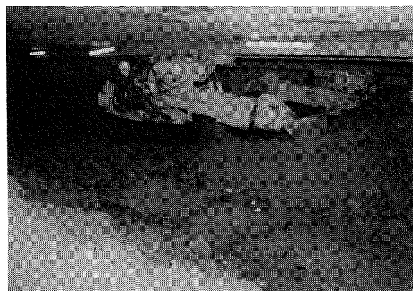
写真-3 天走ショベルによる掘削状況
