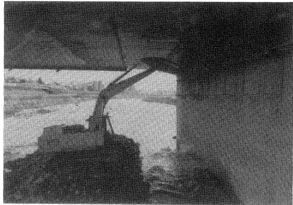
写真-5 仮固定コンクリート解体
