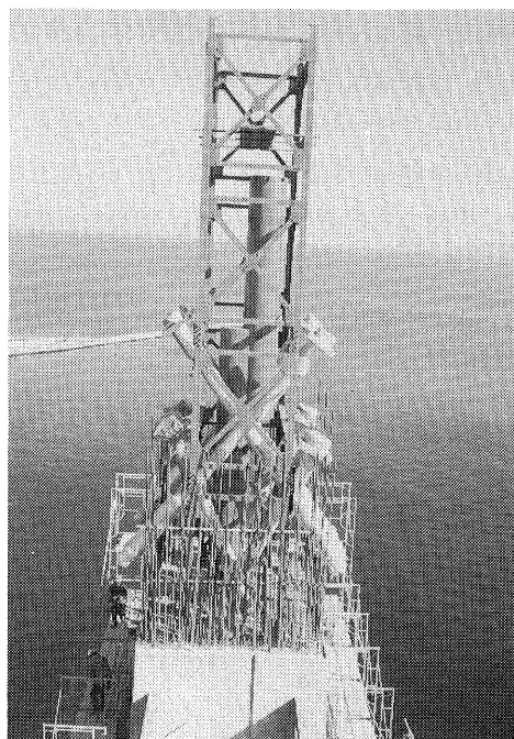
写真3 斜材定着体設置
