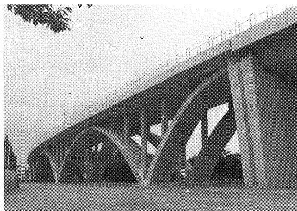
写真-10 平地の橋
