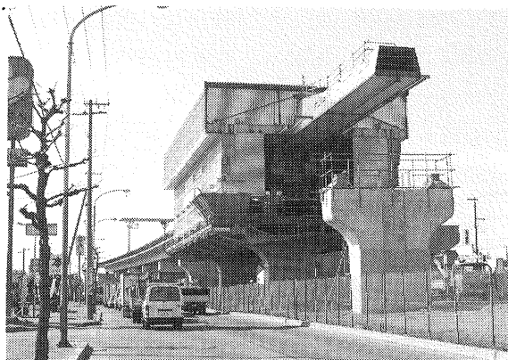
写真－3.4 丘珠高架橋
