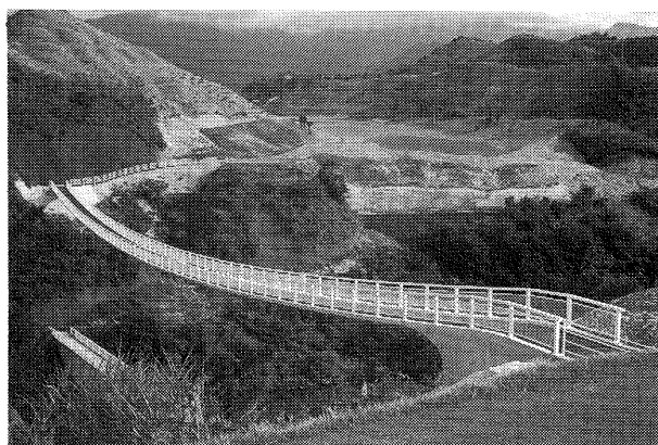
図-11 吊床版橋の一例（石鎚橋）
