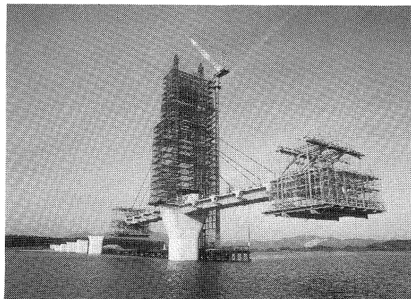
写真-11 吹上浜サンセットブリッジ (建設中)
