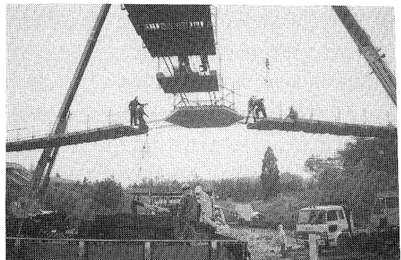
写真-5 中央部架設
