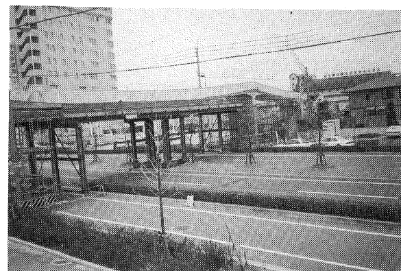
(e) 高欄取付
