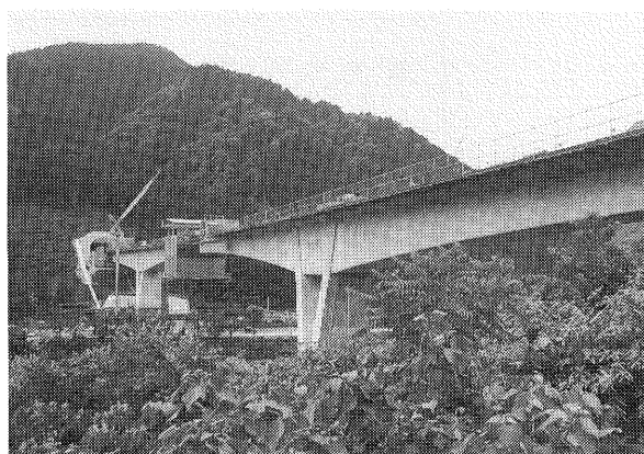
写真-3 張出し施工
