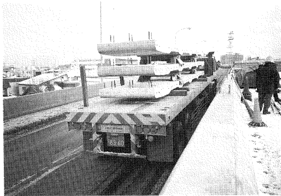
写真— 5. 3 床版の搬入
