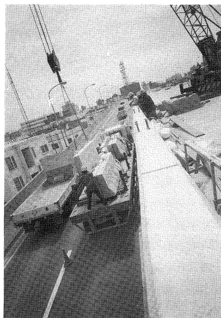
写真-6.3 ブロック搬入
