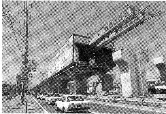
写真-3.3 北栄西高架橋
