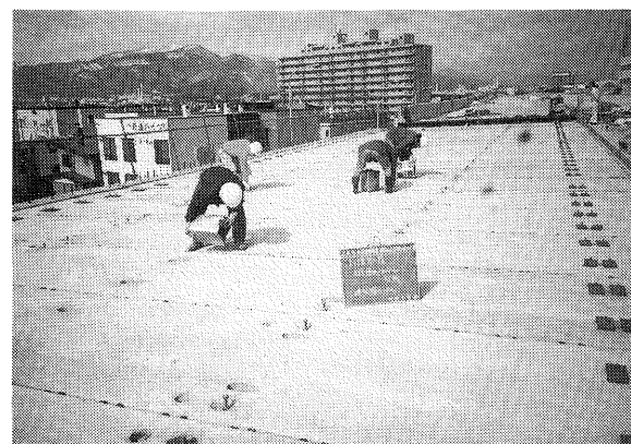
写真— 5. 6 無収縮モルタル打設
