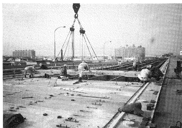
写真— 5. 4 床版の架設
