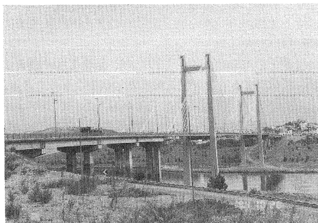
写真-1 エブリポス橋 (ギリシャ)
