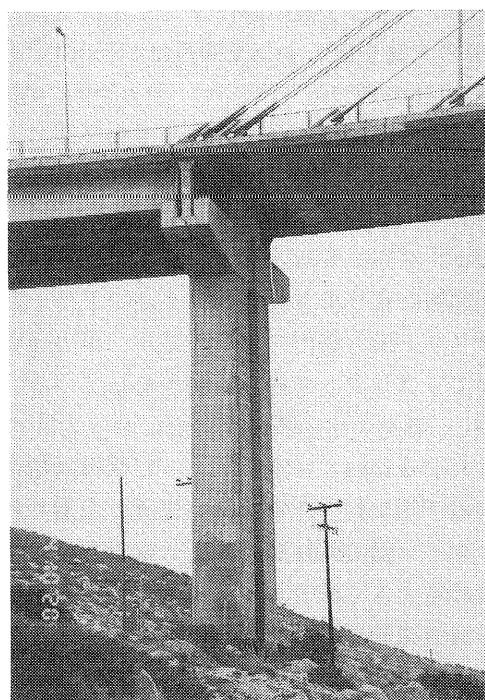
写真-2 エブリポス橋のバックスティ部
