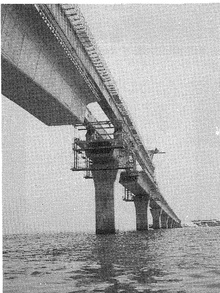
写真-30 ブロック架設中の池間大橋
