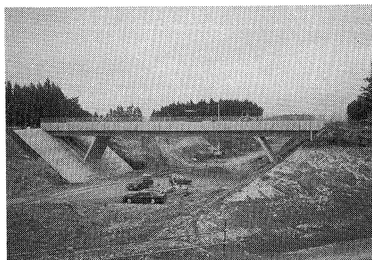
写真-14 工場製作方式、道路公団北海道
