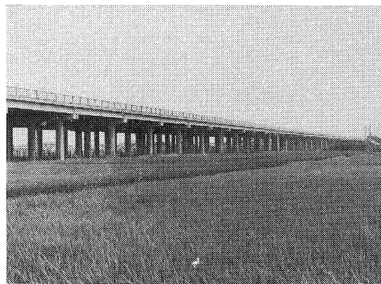
写真－２ プレテン高架橋、小牧高架橋
