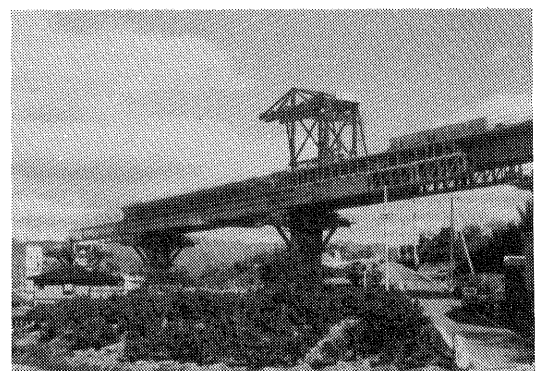
写真-21 施工中の重信川高架橋
