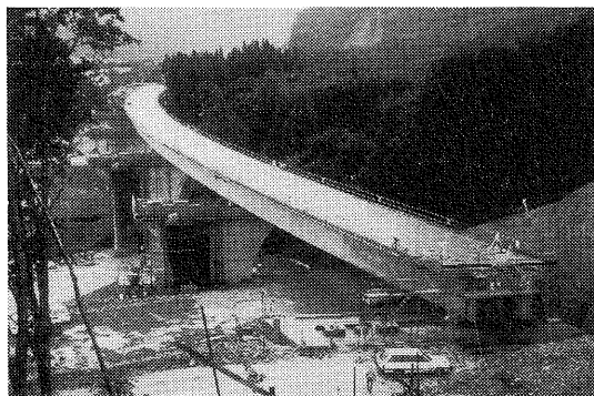
写真-36 全体横取り架設前の岩滑沢橋
