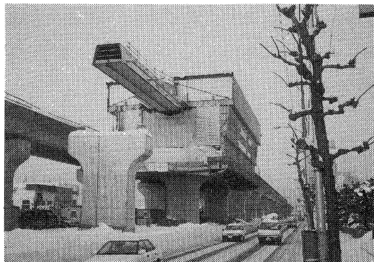
写真-18 冬季施工中の丘珠高架橋
