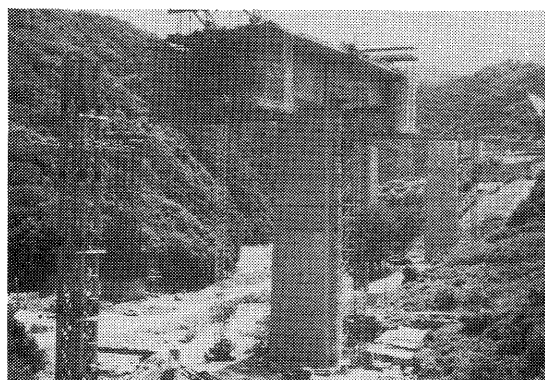
写真-25 仮支柱使用張出し架設中の日川橋
