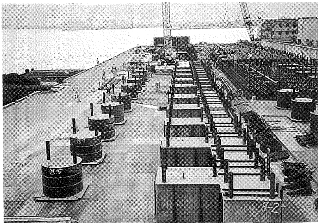
写真－１ 栈橋上部工プレキャストブロックの組立状況
