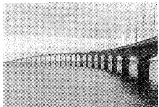
写真-9 レ島橋（全景）
