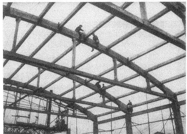
写真 4.7 建設時建方状況
