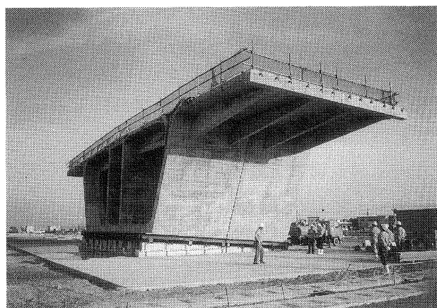
写真-9 木曽三川橋の実大試作プレキャストセグメント
