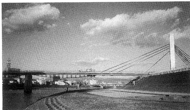
写真-8 斜張定着式張弦構造の香貫橋（沼津市）
