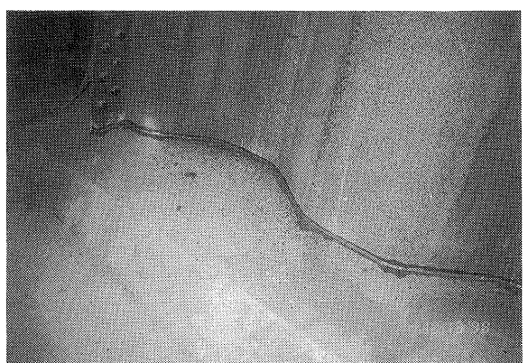
写真4-7 波形鋼板と下床板の接合部
