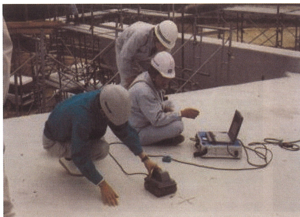
写真２－かぶり測定状況（電磁波法）
