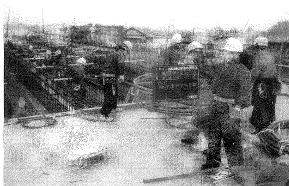
写真13－プレグラウトPC鋼材の設置状況（十号沢橋）
