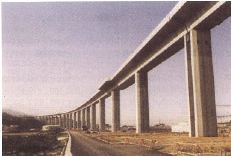
写真15—松山自動車道 重信川高架橋
