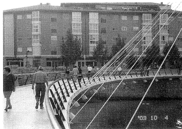
写真 8 ムルシア市、曲線桁斜張橋（歩道橋）
