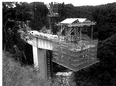
写真21- 前谷橋施工状況
