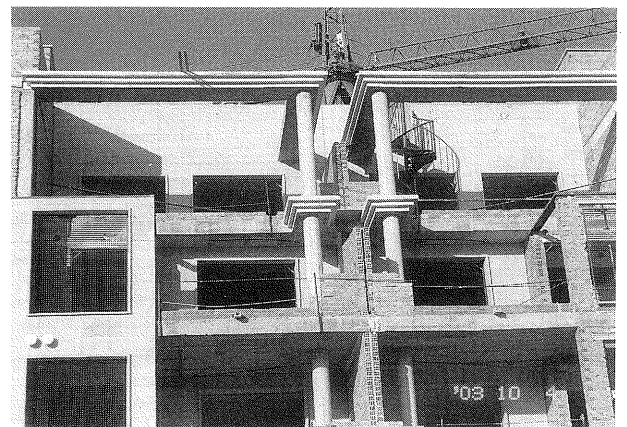
写真 16 低層建築、施工中
