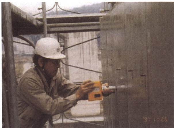
写真１－反発硬度法によるコンクリート強度推定状況
