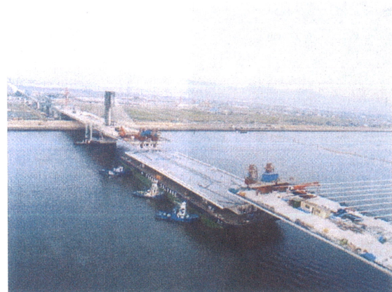
写真 2 7 セグメント架設状況
