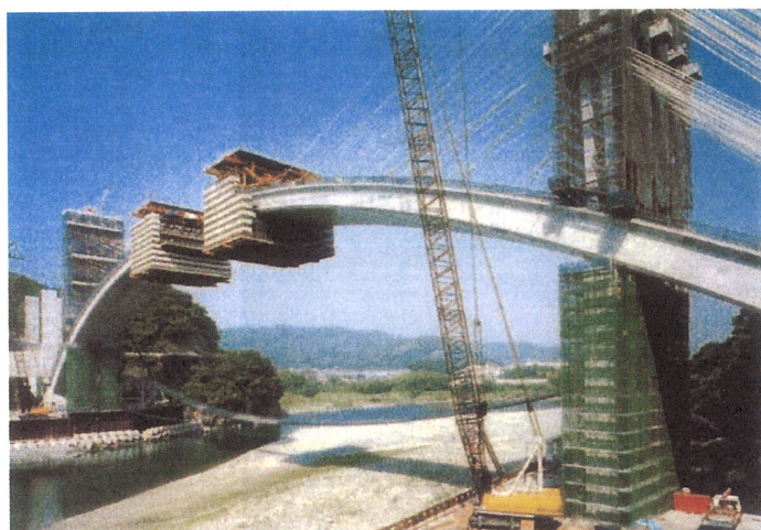
写真 3 2 富士川橋施工状況
