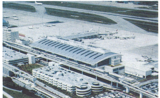
ターミナルビル全景
