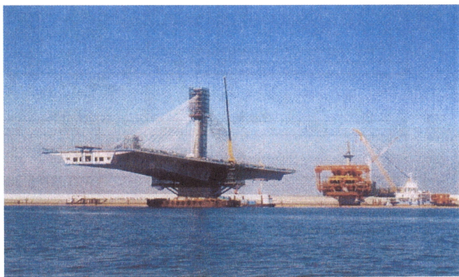
写真 2 8 張出し架設完了状況
