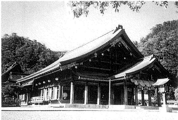
伝統木造建築によりよみがえった拝殿
