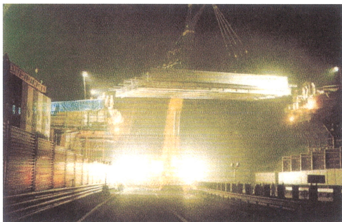
写真 2 2 夜間通行止めによる鋼桁部の架設
