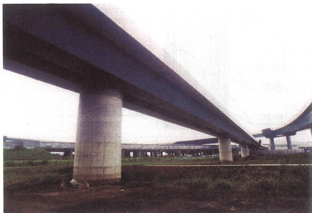
写真35 横浜青葉IC橋
