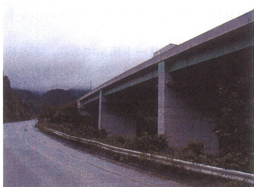
写真 3 3 阿古耶橋全景
