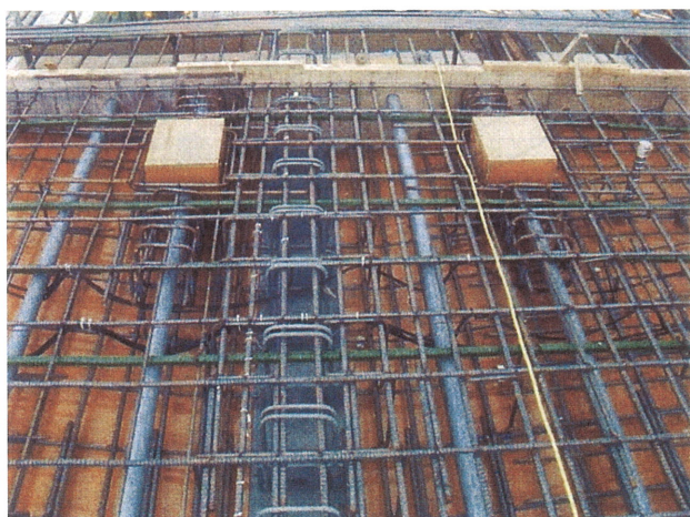
写真15 前谷橋における接合部構造
