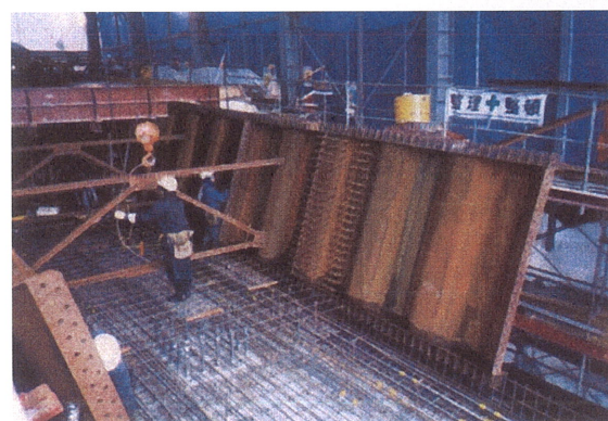
写真9 銀山御幸橋波形鋼板詳細
