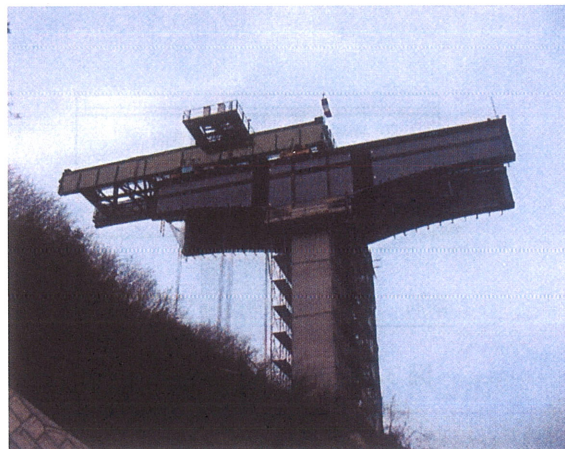
写真37 張出し施工状況
