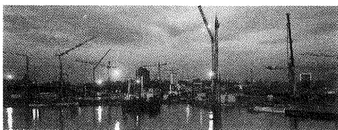
写真-2 ポツダム広場基礎工事 ピット水没
