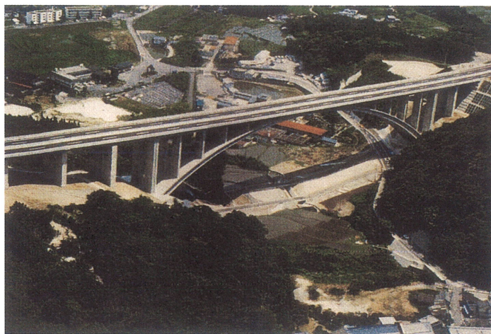
写真31 大分自動車道・別府明礬橋
