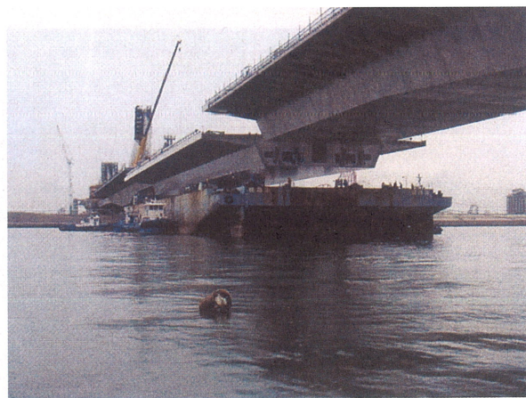
写真 2 9 鋼桁部架設状況
