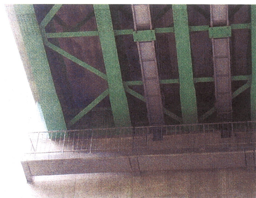
写真 3 4 阿古耶橋接合部
