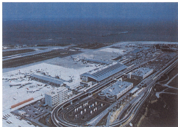
空港ターミナル地域の全体整備状況
