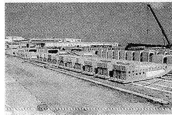
先組みした鉄筋を型枠内にセット
