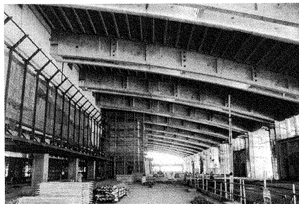
屋根梁架設完了後の状況
