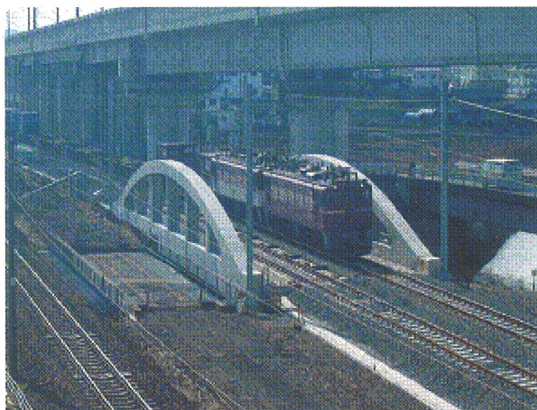
写真－1 荒川橋梁全景
