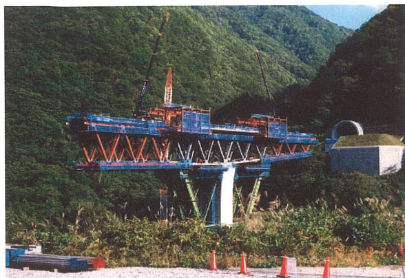
写真6 椿原橋施工状況
