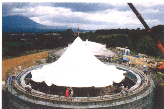
写真-4 空気膜型枠工法によるドームの施工
