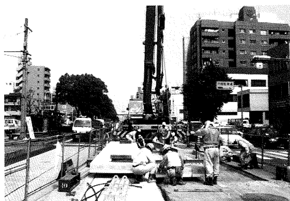
写真-21 道路PC舗装の施工状況
