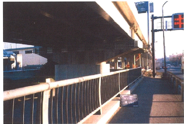
写真-1.2.4 施工完了後
