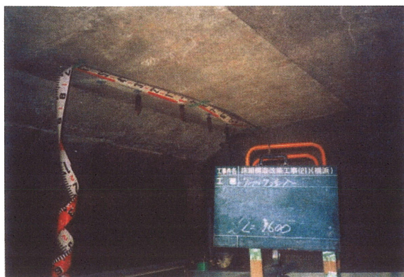
写真-1.4.1 ひびわれ注入工
