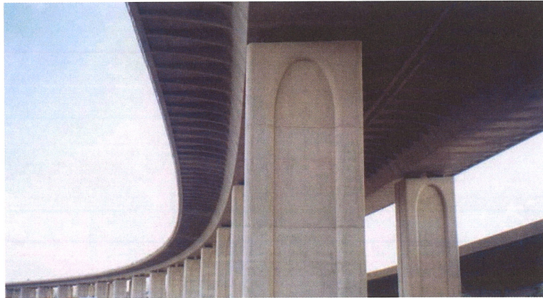
写真11 古川高架橋完成状況
