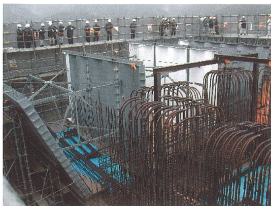
写真5 栗東橋柱頭部施工状況
