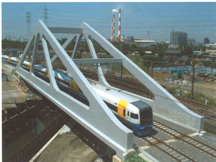
写真－1 姉ヶ崎橋梁全景図
