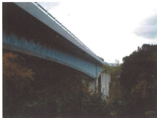
写真3 小河内川橋完成状況
