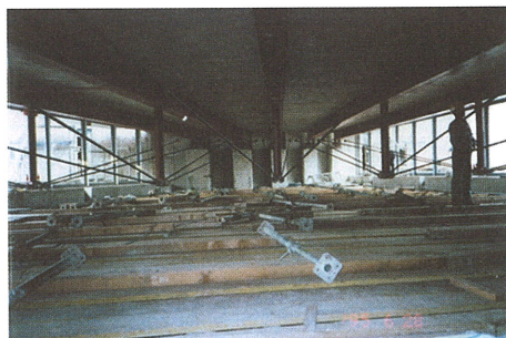
写真3.2.5 鉄骨張弦梁の施工状況
