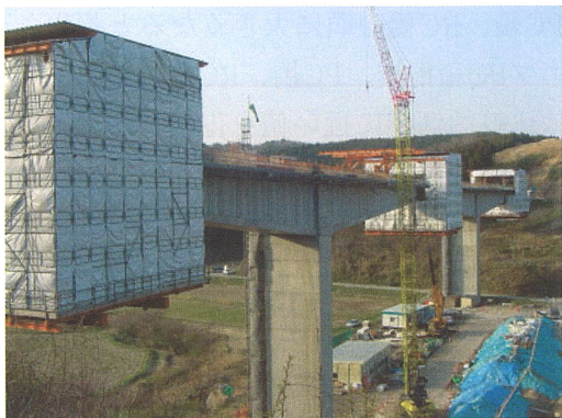
写真2 勝手川橋施工状況
