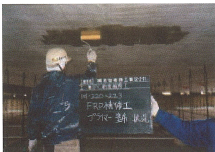
写真-1.3.2 プライマー塗布工
