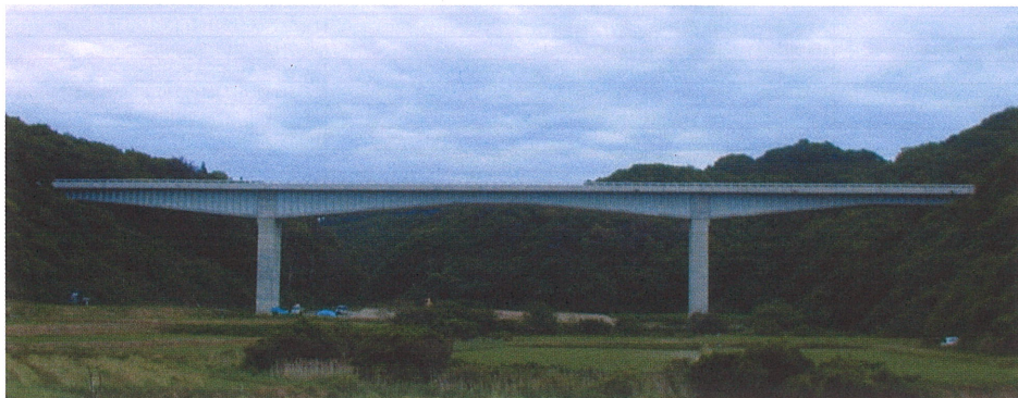
写真1 勝手川橋完成写真
