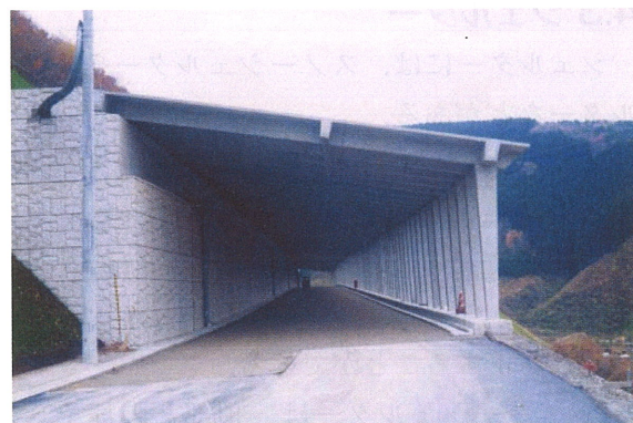
写真-17 スノーシェッド
