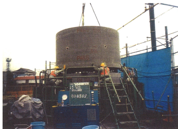
写真-24 PCウェルの施工状況
