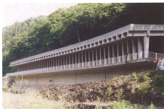
写真-16 ロックシェッド
