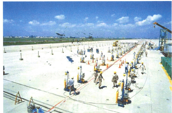
写真-20 空港エプロンPC舗装のリフトアップ
