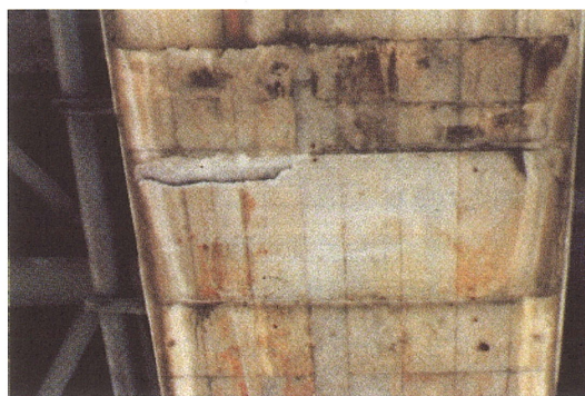
写真-2.4.3 跡埋めコンクリートの損傷状況
