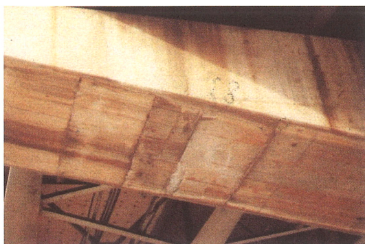
写真-2.4.3 跡埋めコンクリートの損傷状況
