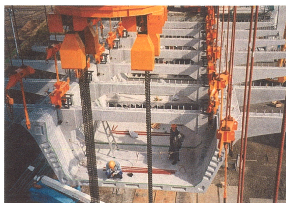
写真10 コアセグメント施工状況
