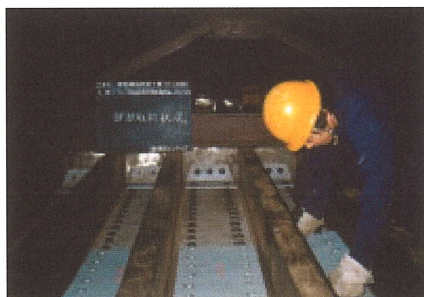
写真-1.1.5 下フランジ補強材取付け状況
