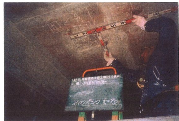
写真-1.4.2 断面修復工
