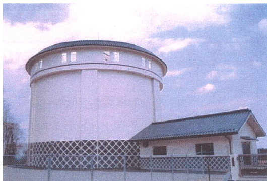
写真-1 ポストテンション工法による貯水槽
