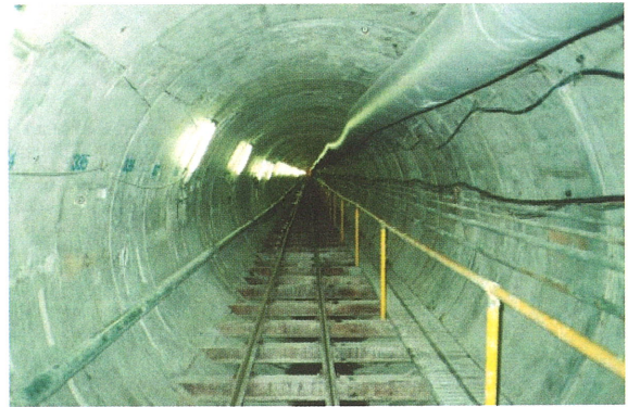
写真-22 PCセグメントを用いたシールドトンネル
