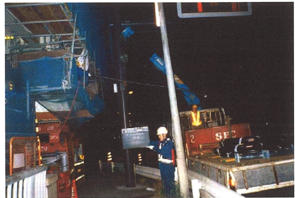
写真-1.2.2 ケーブル搬入工
