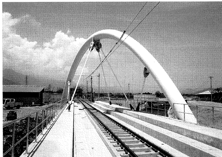
写真－1 除沢橋梁全景
