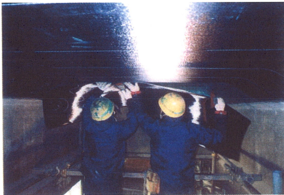
写真-1.4.5 炭素繊維シート貼り付け状況
