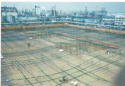
写真3.2.2 フラットスラブのアンボンド tendon
