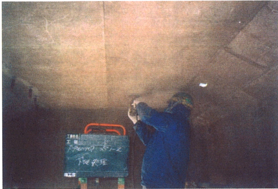
写真-1.4.3 下地処理状況
