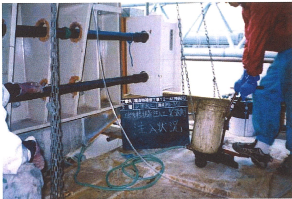
写真-1.2.1 エポキシ樹脂注入工
