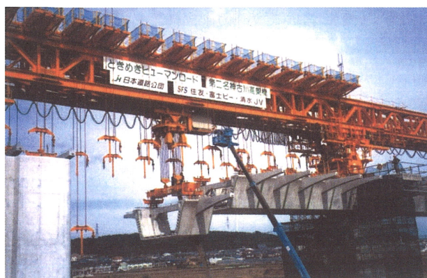
写真10 コアセグメント施工状況
