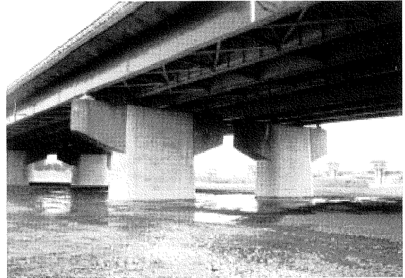
写真-30 壁式橋脚耐震補強の事例
