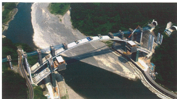
写真8 富士川橋施工状況
