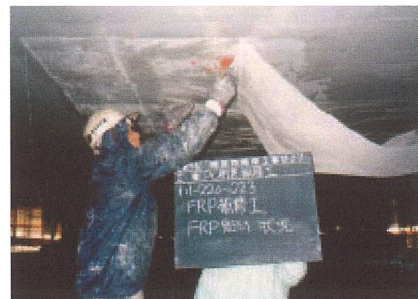
写真-1.3.3 FRP貼り付け工
