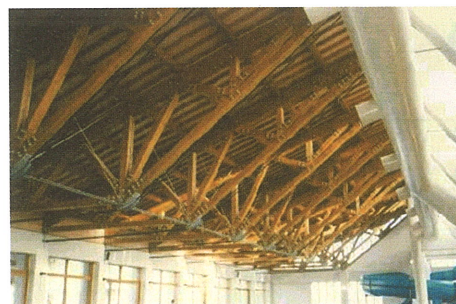
写真3.2.6 集成材トラスたわみ制御
