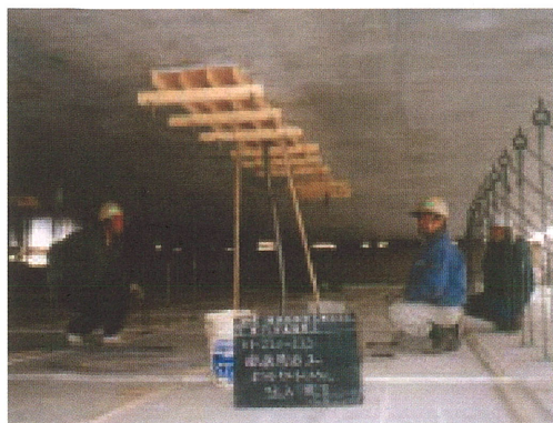
写真-1.3.1 グラウト注入工
