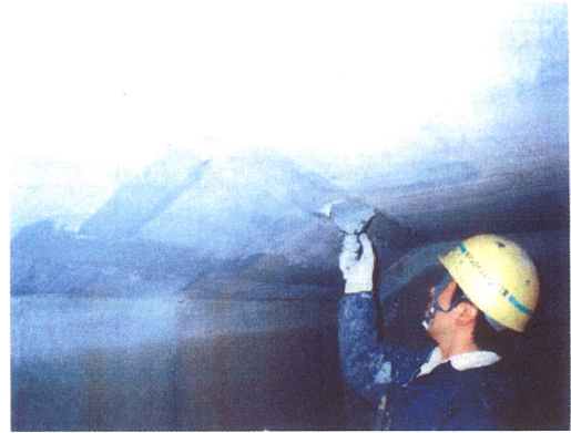
写真-1.4.6 表面仕上げ工
