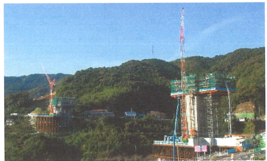
写真4 日見橋施工状況
