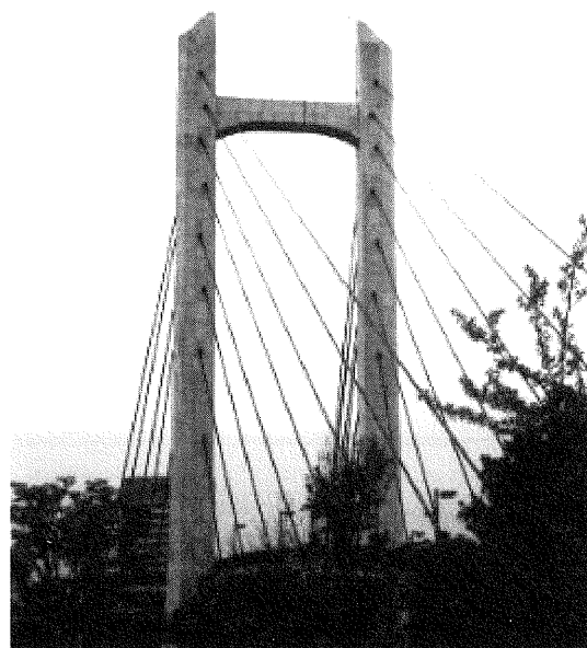
写真-2 木場公園大橋の主塔
