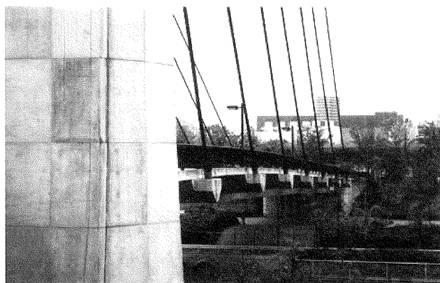
写真-1 木場公園大橋の斜材
