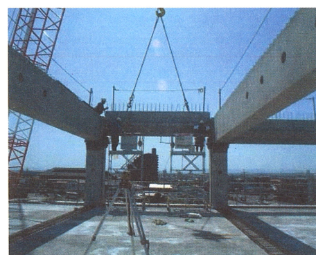
写真3.2.11 梁部材(桁行方向)建方状況
