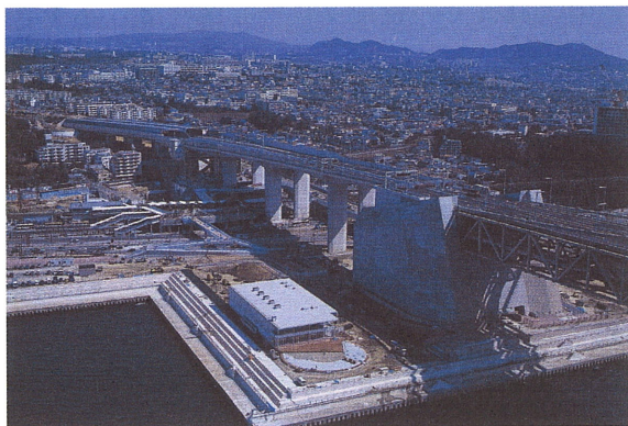
写真－１ 舞子高架橋
