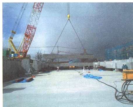
写真3.2.7 1階梁部材 建方状況
