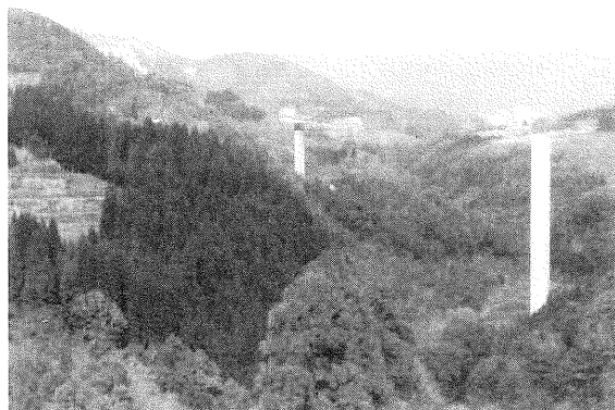
図-3.4 上岩戸大橋(橋脚高さ104m)
