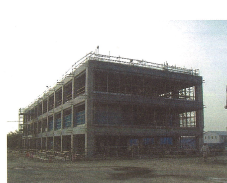
写真3.2.13 建方完了状況
