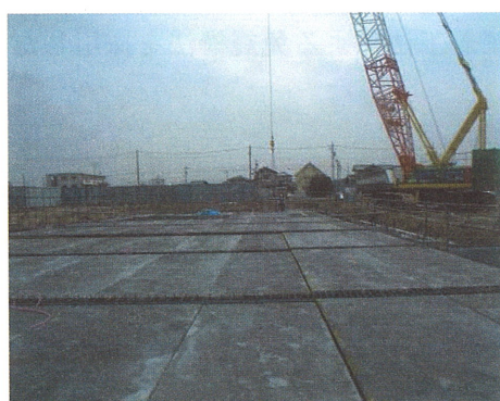
写真3.2.8 1階床部材 建方状況
