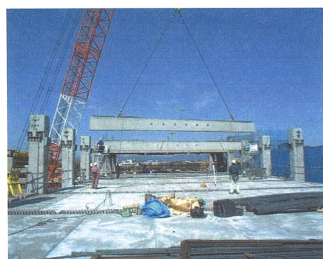
写真3.2.10 梁部材(張間方向)建方状況
