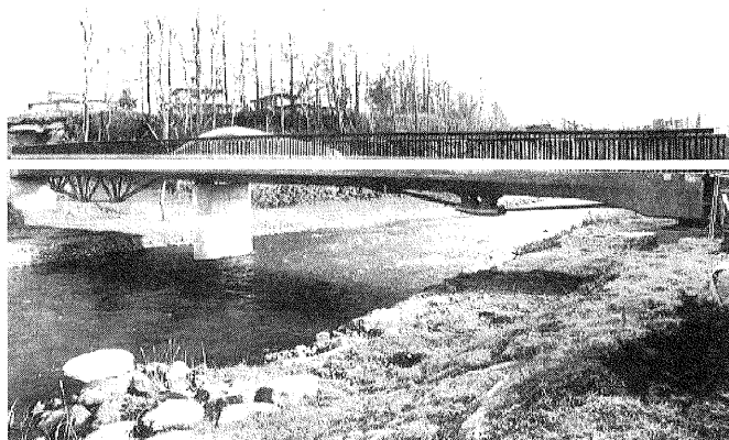
写真ー4 望景橋
