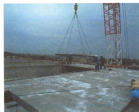
写真3.2.12 床部材 建方状況
