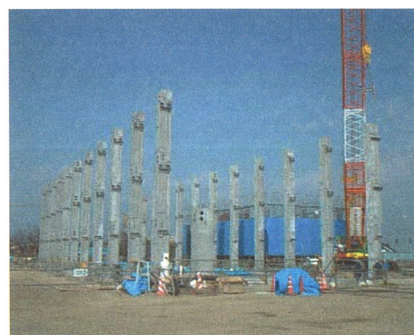
写真3.2.9 柱部材 建方状況
