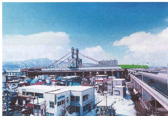
桁押し出し状況
