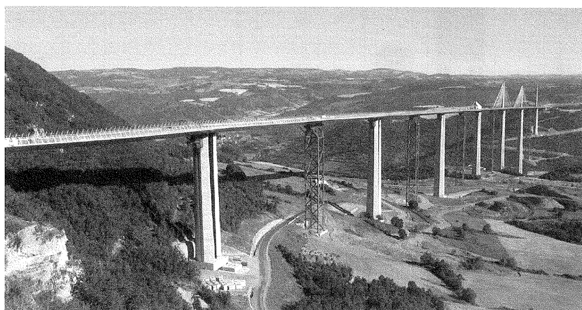
写真－3.4 2004年6月の状況
