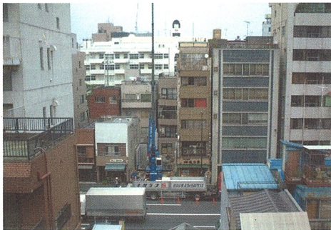
写真-5.1.1 建方風景 1
