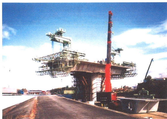
張出し架設状況
