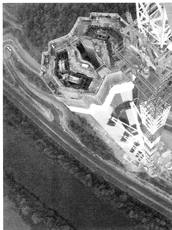
写真－3.11 P2橋脚の頭部
