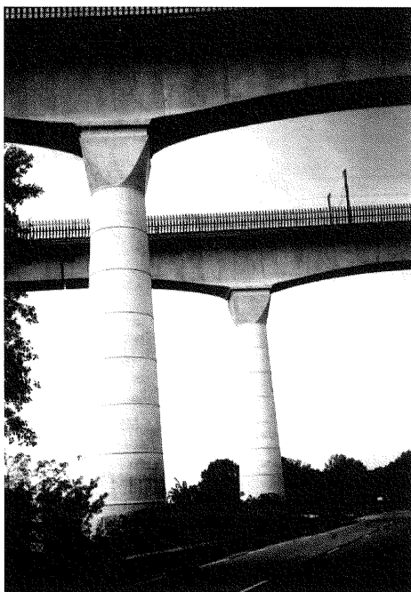
写真-2.3 円形断面の橋脚
