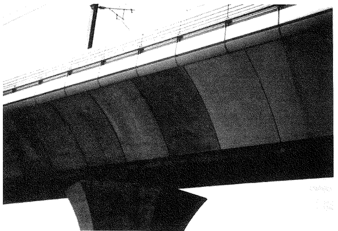
写真-2.11 プレキャストの補強ウェブ
