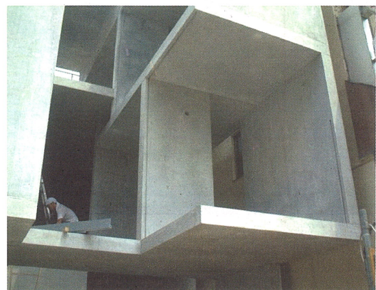
写真-5.1.5 2階片持ち部
