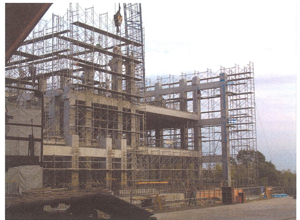
写真-5.2.4 架構組み立て状況
