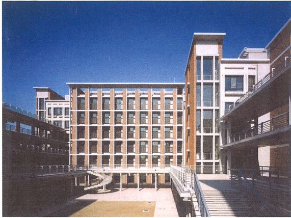
写真-5.2.1 A棟と中庭コミュニティ空間
