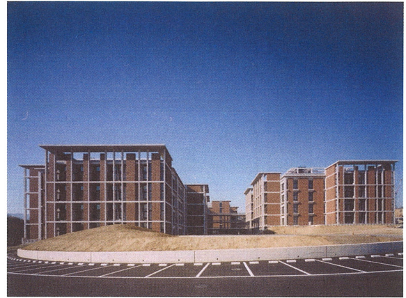
写真-5.2.2 B及びC棟全景
