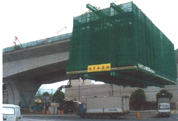
張出し架設状況(同国道 勅使高架橋工事:香川県)
