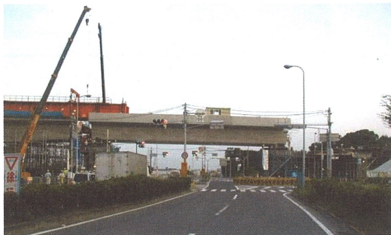
夜間押し架設完了時
