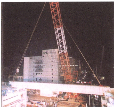
桁架設状況（夜間）
