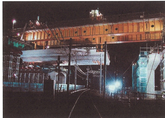
桁架設状況（夜間）
