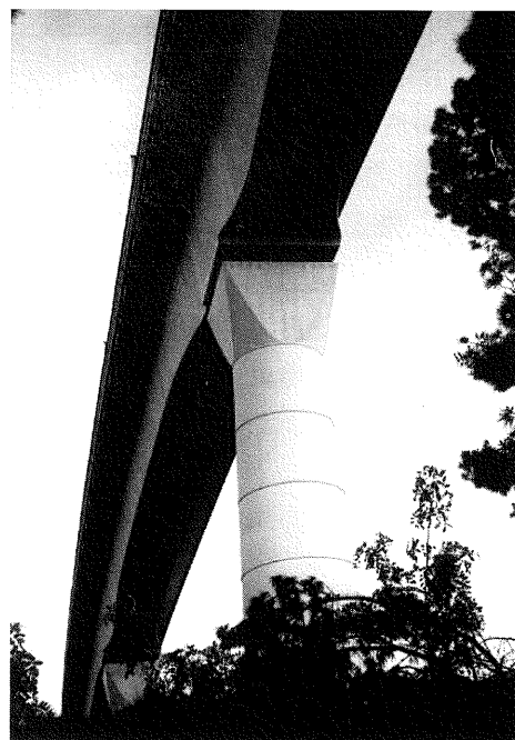
写真-2.4 主桁と橋脚
