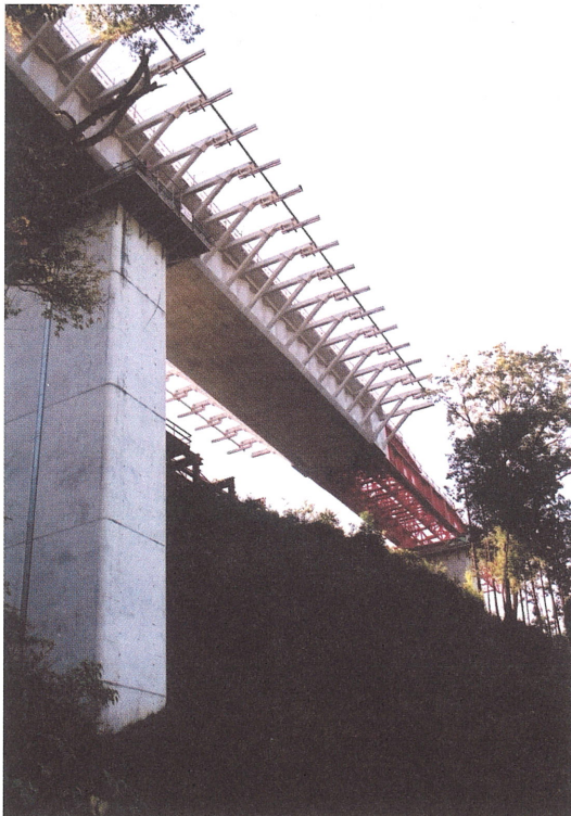
図-19 コア断面による押出し架設
