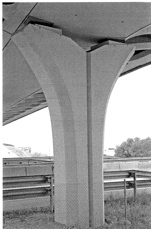
写真-15 Y形橋脚
