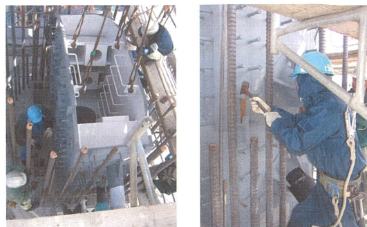
図-26 鋼殻の架設状況
