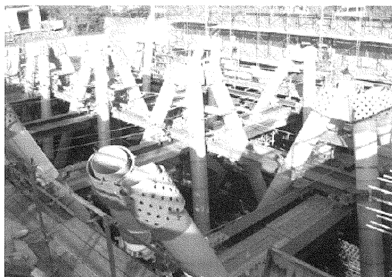
図-51 側径間部の鋼トラス材の架設状況
