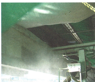
写真-9 はつり状況
