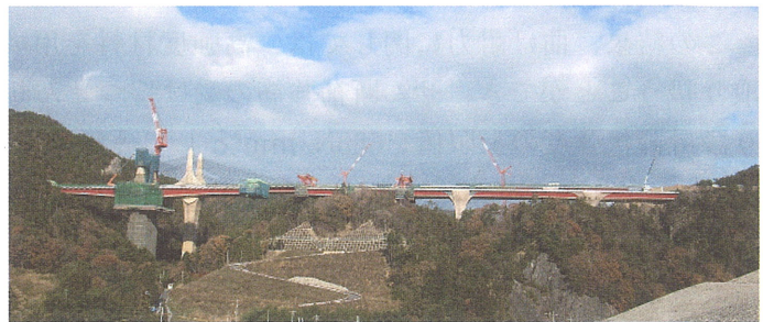
図-30 栗東橋施工状況
