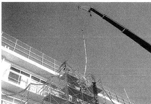
図3.3.1-10 斜めPC鋼材配線
