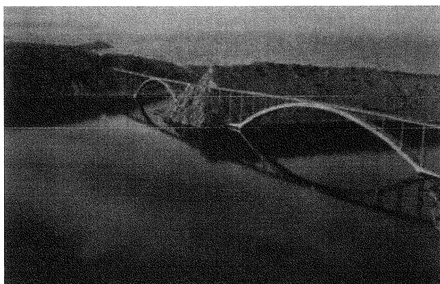
図-18 Krk橋（右側が支間390mのKrk I 橋）
