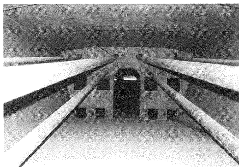
写真-4.1 支点横桁へ定着する例
