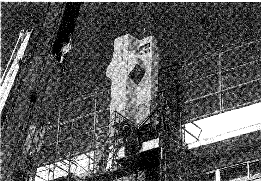
図3.3.1-8 PCa柱建て込み
