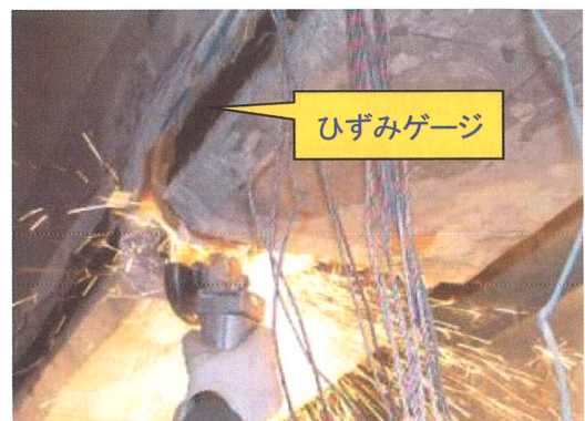
写真-3 PC鋼材切断状況
