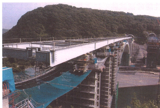
図-42 補剛桁の送出し架設
