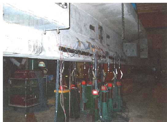
写真-4 載荷実験状況
