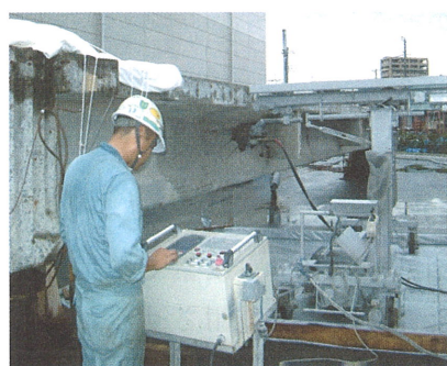
写真-8 WJはつりに用いたロボット
