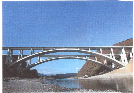
図-39 第二東名高速道路 富士川橋
