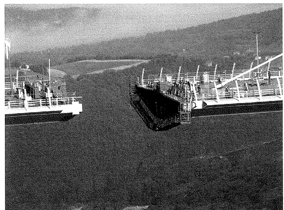
写真-8 タルヌ溪谷上での桁の閉合
