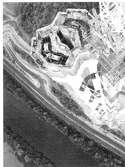
写真-2 橋脚頭部
