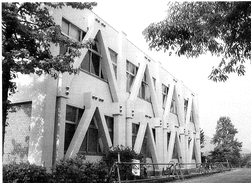
図3.2.2-2 大学校舎補強例
