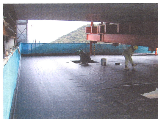
図-28 作業床の防水
