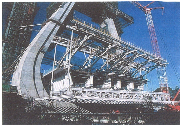
図-36 組立中の超大型移動作業車
