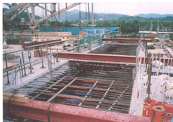
図-38 側径間閉合部の施工状況
