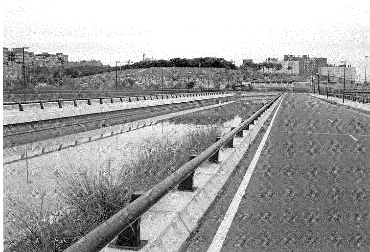
写真-17 運河橋の橋面
