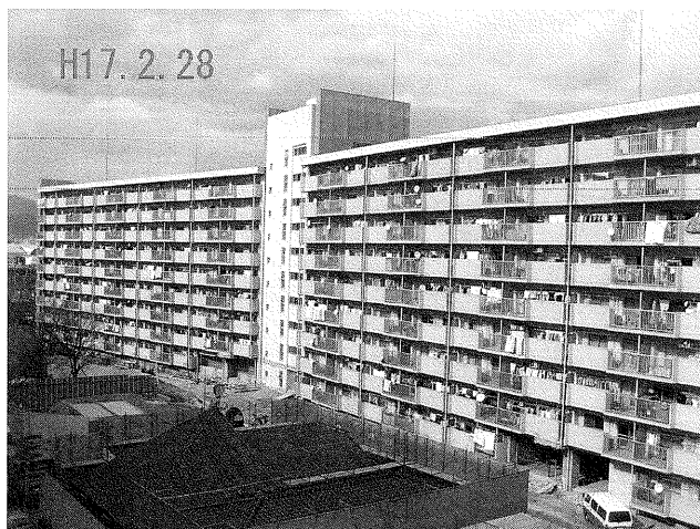
図3.1.3-3 集合住宅（改修前）
