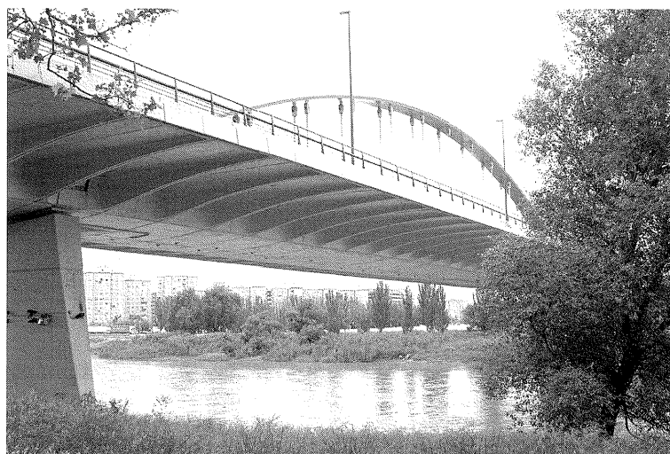
写真-19 エブロ川に架かる単弦ローゼ橋
