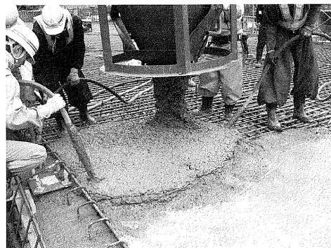
写真-3.25 床版の打設状況
