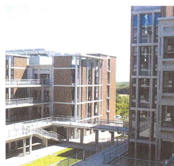
A-1棟とPCaPCデッキ
