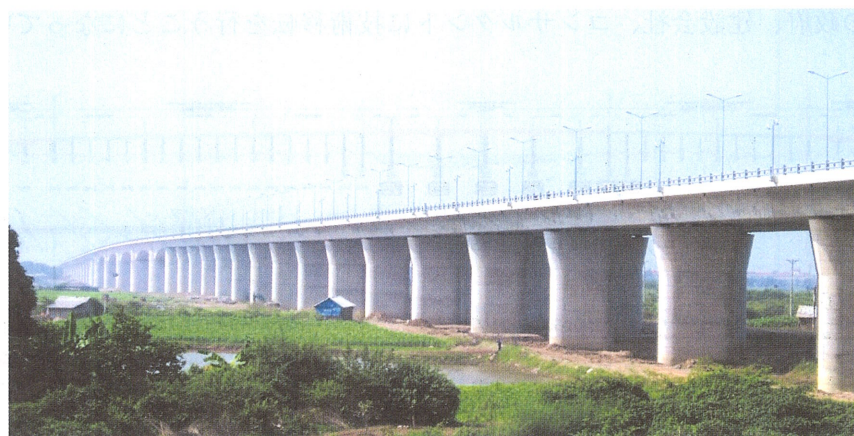
写真-2 タイinch橋全景
