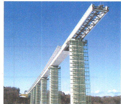
写真-3.8 鳥崎川橋全景
