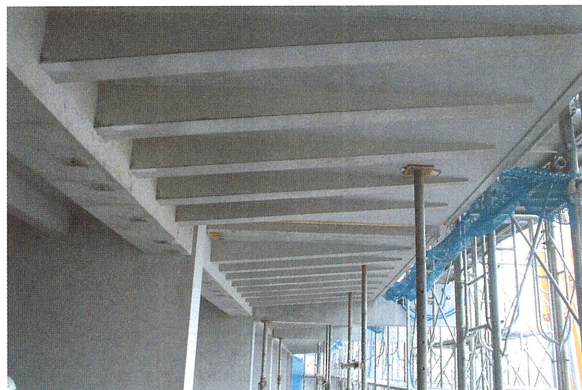
外廊下 施工中
