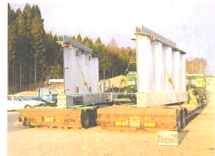
写真-3.9 UFC下弦材付き手延べ桁
