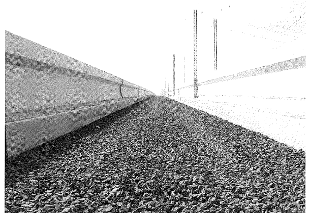
写真-2.4 橋面の状況
