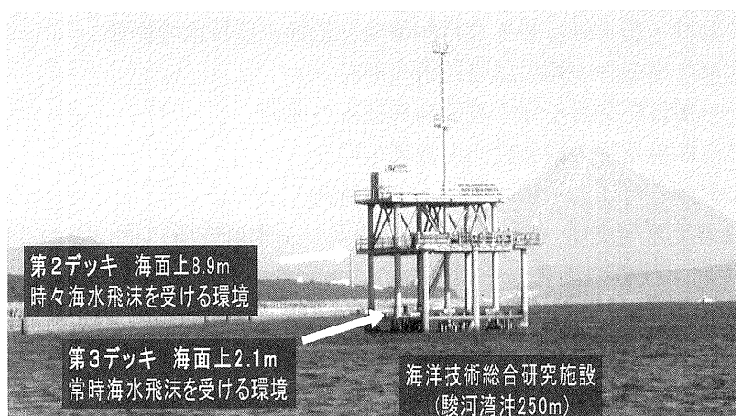
写真－１ 海洋技術総合研究施設
