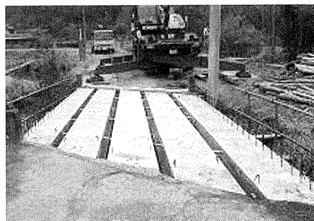
写真-3.14 架設完了後の状況
