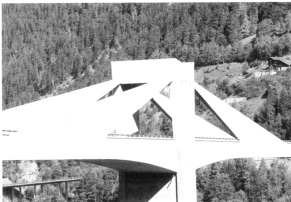
写真-2.9 塔、斜材、桁および橋脚の一体化
