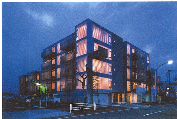
建物全景写真
