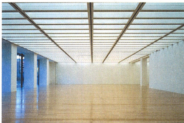
天吊式パネルレールとPC床版リブ
