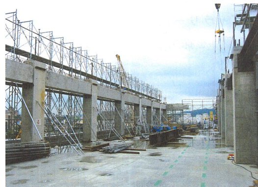
PCa柱およびPC圧着梁の仮設状況
