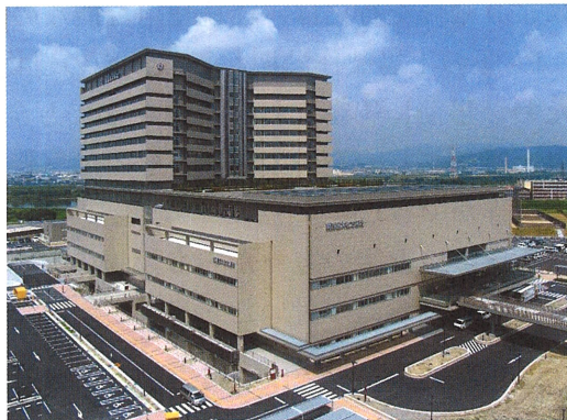
建物外観写真
