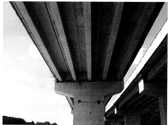
写真－9 ドブラ橋 桁下面
