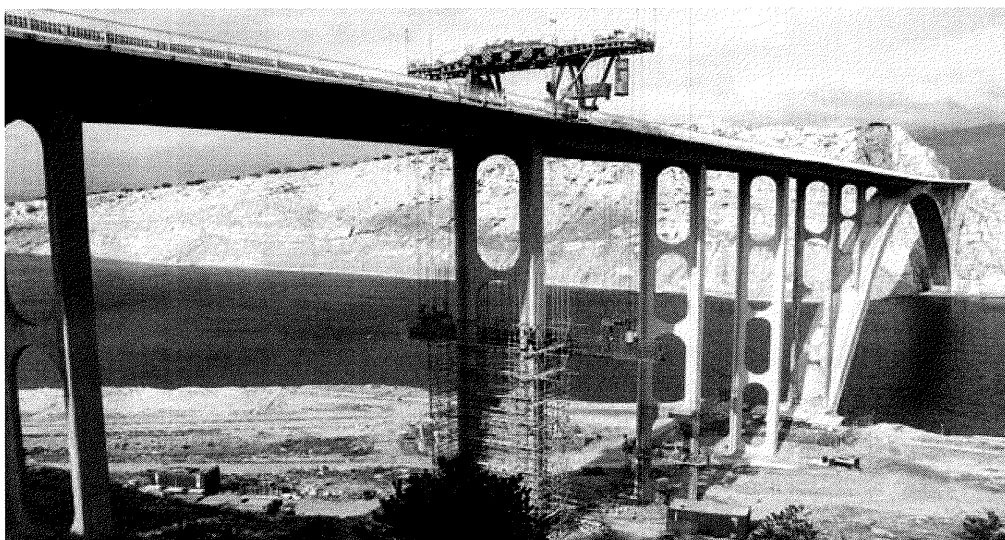
写真-31 補修・補強施工状況
