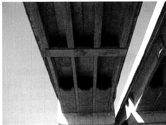
写真－7 ドレズニック高架橋 渡河部（桁下面）
