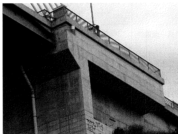
写真-13 鋼斜張橋部側のアンカー橋台
