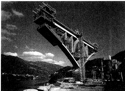
写真-3.4.1 トラス片持架設(池田へそっ湖大橋)
