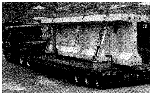
写真－3.2.2 低床トレーラー運搬
