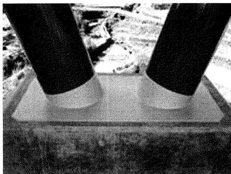
写真-2.7 ウレタン防水工（木ノ川高架橋）
