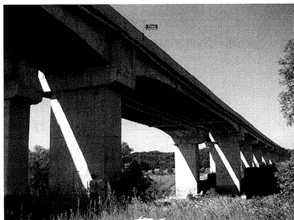
写真－6 ドレズニック高架橋 渡河部（側面）
