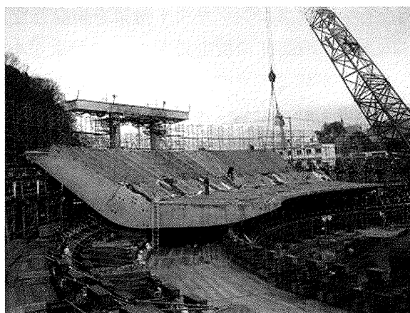
写真2 PCa工事状況
