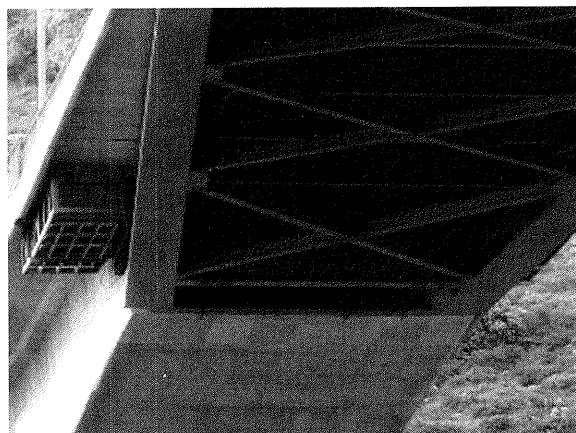
写真-12 中央ヒンジ部（下面）
