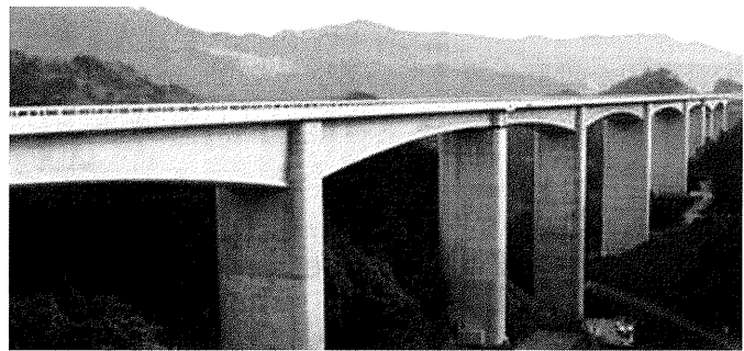
写真-4.2 完成写真
