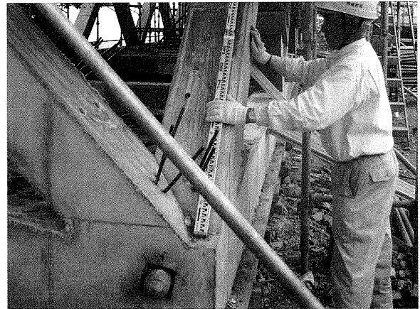
図3.2 パネルゾーン打設後
