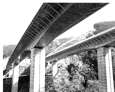
写真-3.5.5 ストラット付き床版箱げた橋 (芝川高架橋)
