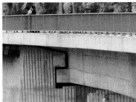
写真-14 PC橋部側の橋台
