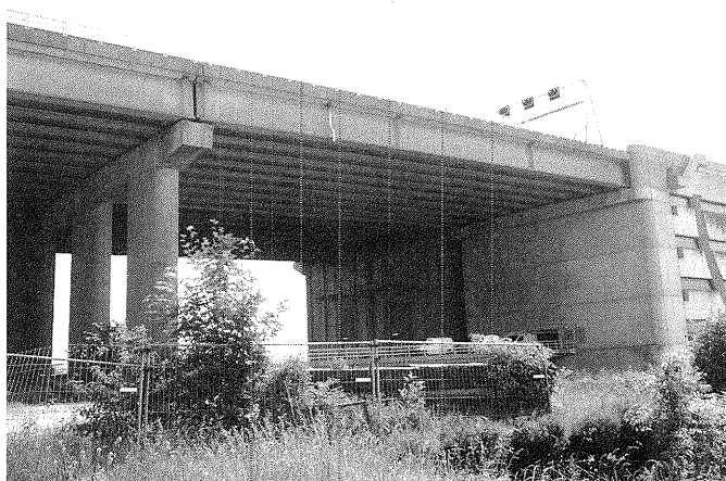
写真－11 ファンブリネンノード橋可動橋部
