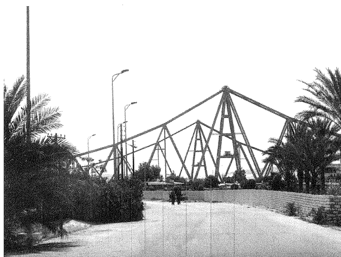
写真-12 フェルダン鉄道橋
