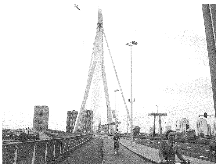
写真－7 エラスムス橋橋面
