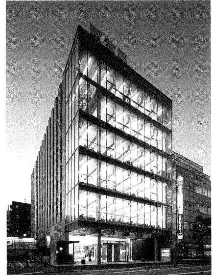
図5.1.2 建物全景（南西面）
