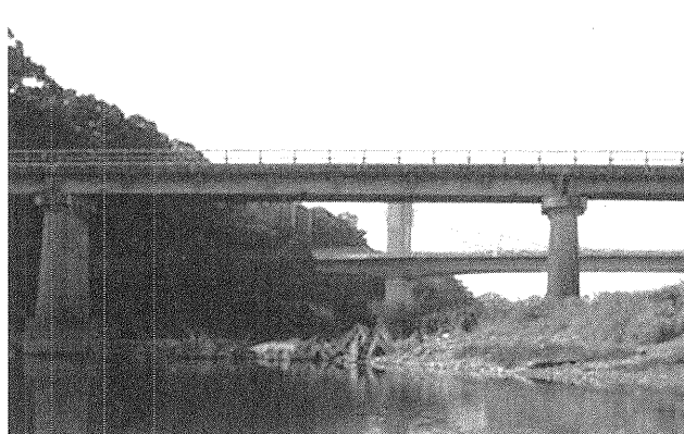
写真-5.10 新旧の南筑橋 (平成19年12月撮影)
