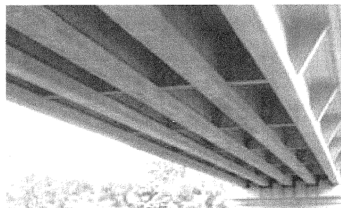
写真-5.9 現在の主桁の状態
