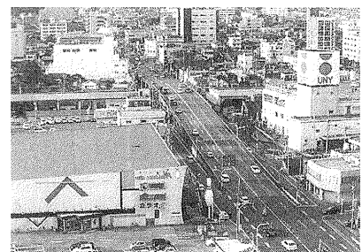
写真-5.1 太田跨線橋
