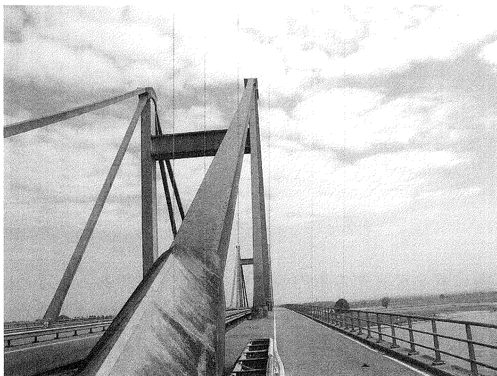
写真－5 ケーブルコンクリート被覆
