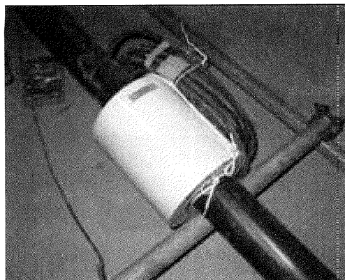
写真-4.5 EMセンサーの計測事例 6)
