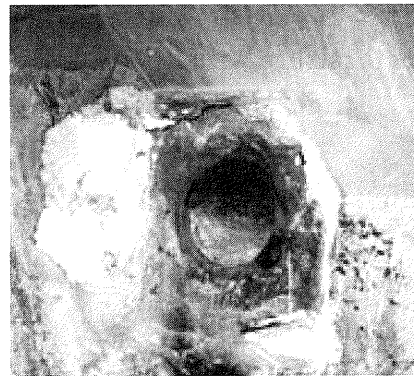
写真-6.2 Niles Channel Bridge定着具近傍の損傷 2)
