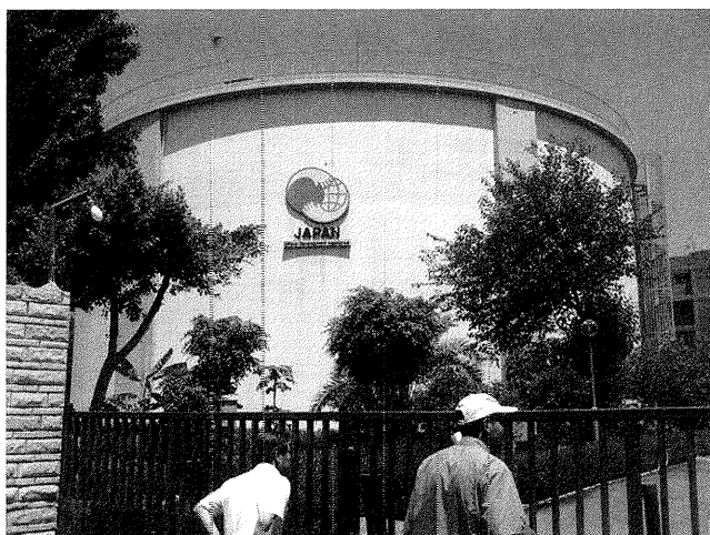
写真-14 PC水タンク
