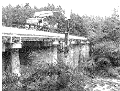
写真一4.1 橋梁点検車による点検
