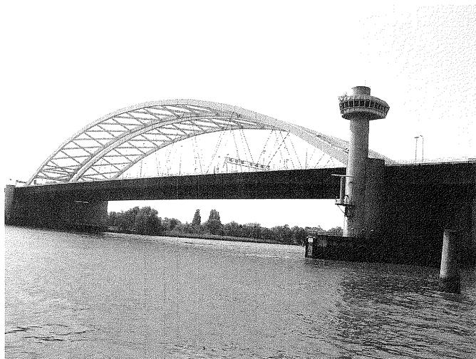
写真－10 ファンブリネンノード橋アーチ橋部
