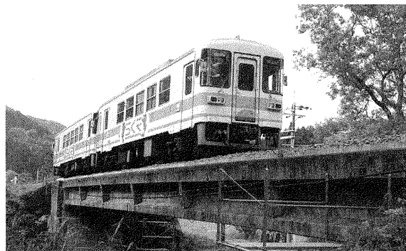
写真-5.5 現在の第一大戸川橋梁
