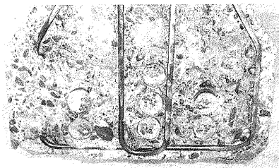
写真-5.2 主桁切断面
