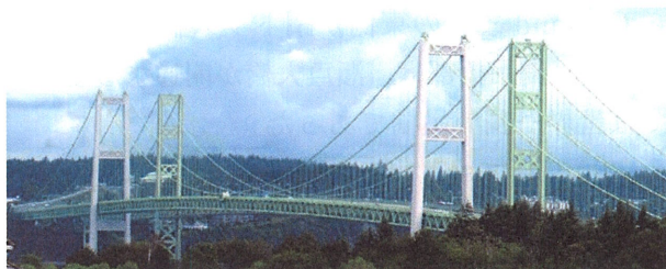
写真－25 Tacoma Narrows 橋
