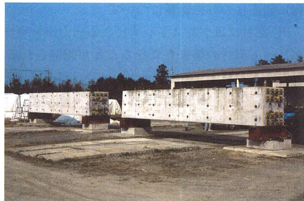
写真-5.1 ASR劣化試験体 5-12)
