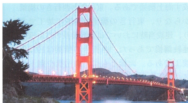
写真-20 Golden Gate 橋
