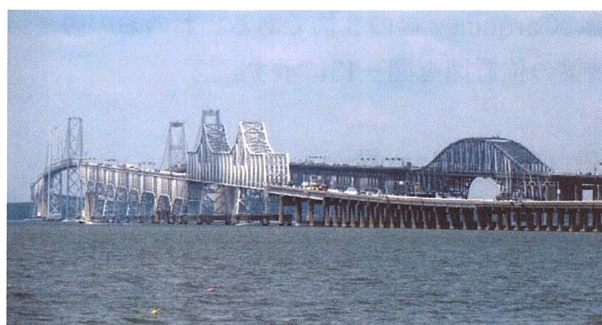
写真-19 Chesapeake Bay 橋
