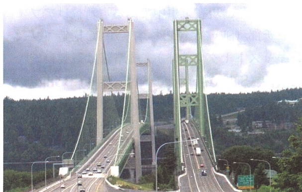
写真－26 Tacoma Narrows 橋（左が新橋）
