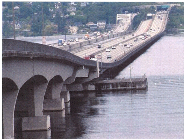
写真－28 Homer M. Hadley Memorial 橋（右側）
