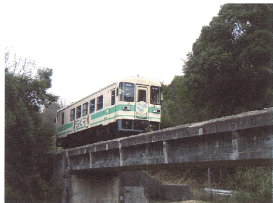
写真-2.3 第一大戸川橋梁
