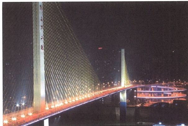
写真－4 Second Wujiang 橋
