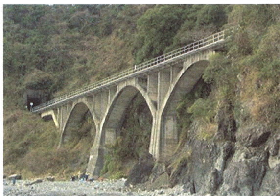
写真－1.1 土讃本線第二領地橋梁 (1938年建設)
