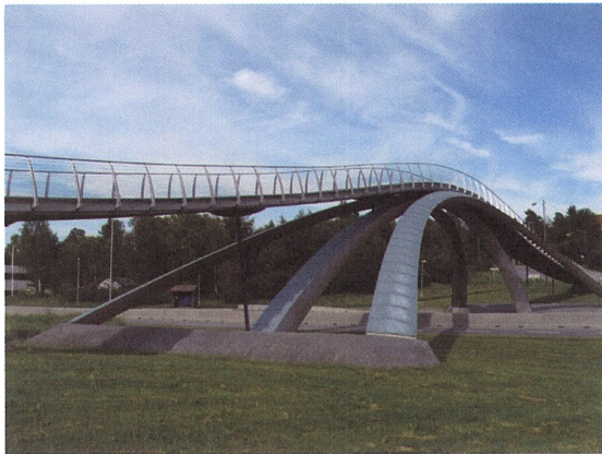
写真-2.15 レオナルド橋
