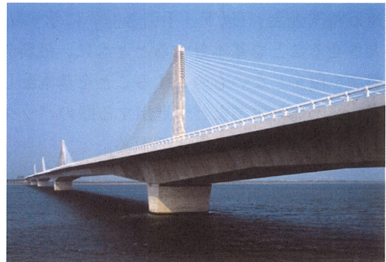
写真-6 木曽川橋・揖斐川橋
