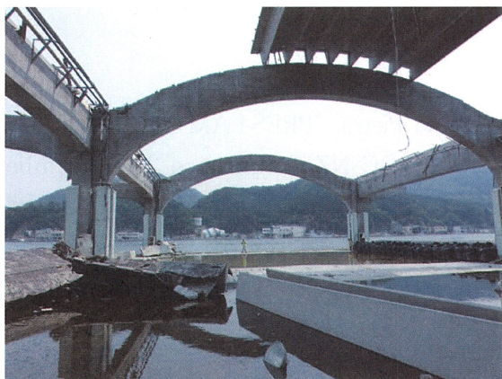
図-14 津波により落下したプレキャスト屋根版
