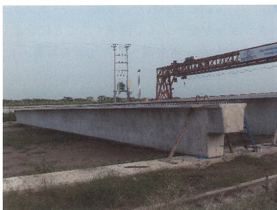
写真-1.10 取付橋用のプレテン桁
