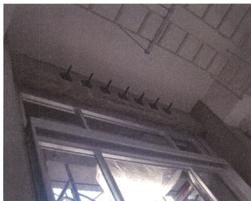
外付けフレームの圧着
