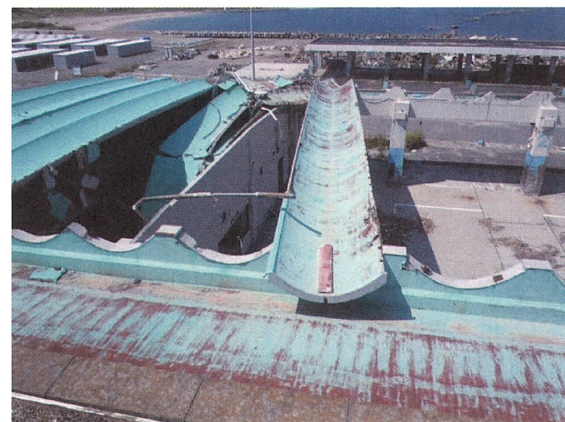
図-14 津波により落下したプレキャスト屋根版
