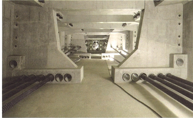
写真21 外ケーブルに ECF 高強度 PC 鋼材を使用された桁内の状況
