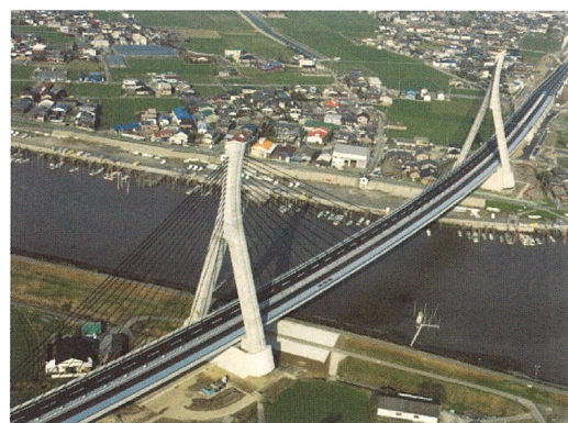
写真-17 矢部川橋
