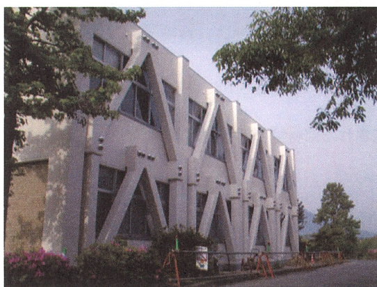
コンクリートブレースによる補強
