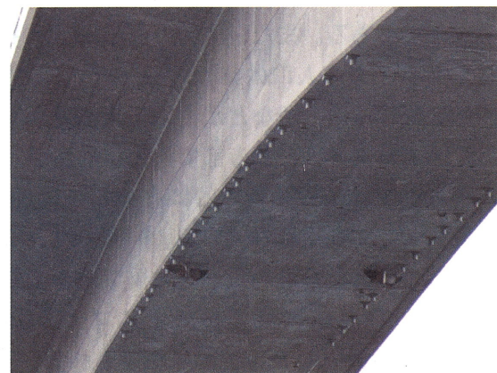
写真－2.9 せん断鋼棒による補強
