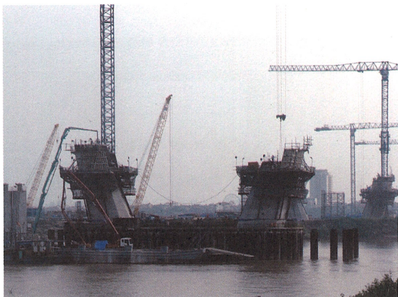
写真-1.8 ニャッタン橋視察時の工事状況
