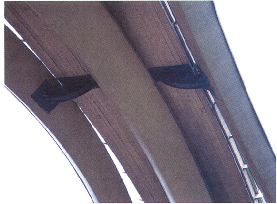
写真-2.16 アーチリブおよび床版下面
