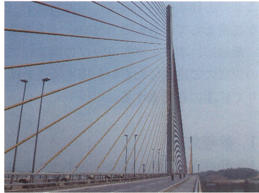
写真-1.13 バイチャイ橋の最新状況 —橋面から主塔を望む—
