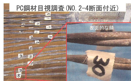
写真-3.6 解体調査その2
