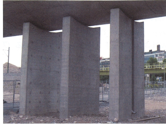
写真－2.6 構造上の機能を持たない橋脚
