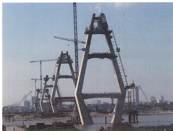
写真-1.12 ニャッタン橋の最新状況
