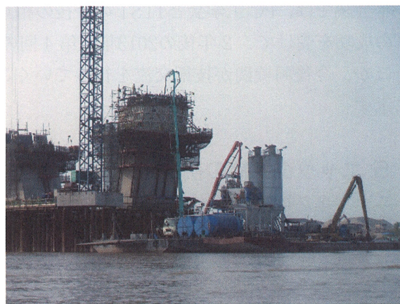
写真-1.11 生コンプラント船による施工
