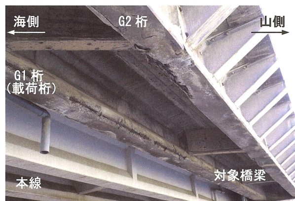
写真-3.1 撤去前の状況
