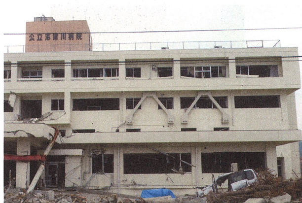
志津川病院東棟（南三陸町） （昭和49年建設、平成17年度耐震補強）
