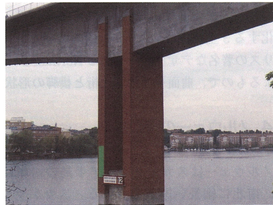
写真－2.8 レンガ貼り二枚壁式橋脚
