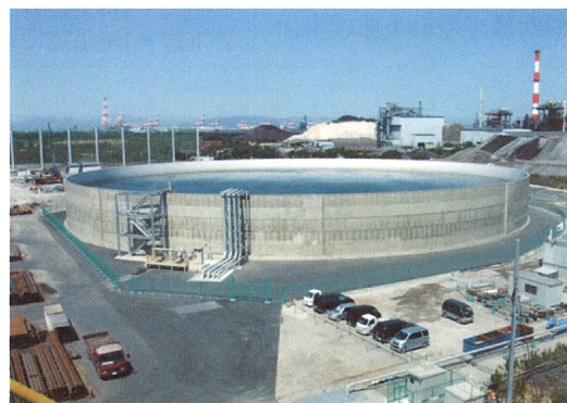
写真-19 南部雨水排水調整槽
