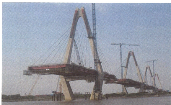
写真－1.9 施工中のニャッタン橋（2013年）
