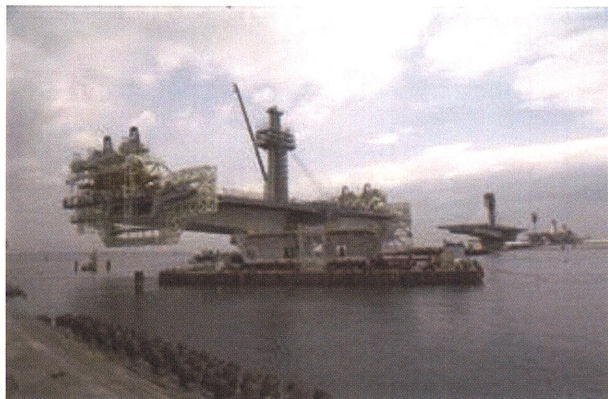
写真-5.3 木曽川橋・揖斐川橋の架設状況
