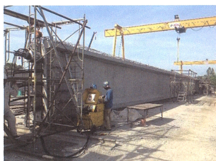
写真-3.4 PCI 桁製作状況
