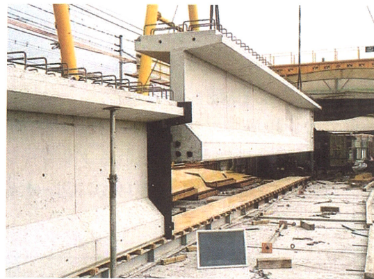
写真-3.8 PC コンボ橋の主桁製作状況
