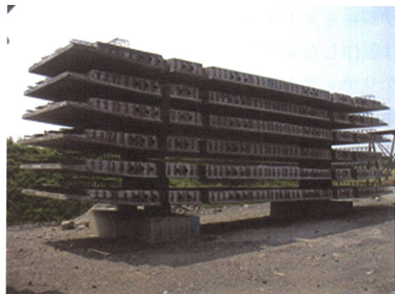
写真-5.23 床版部材
