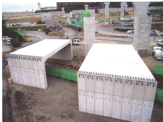
写真-5.12 大型ボックスカルバート
