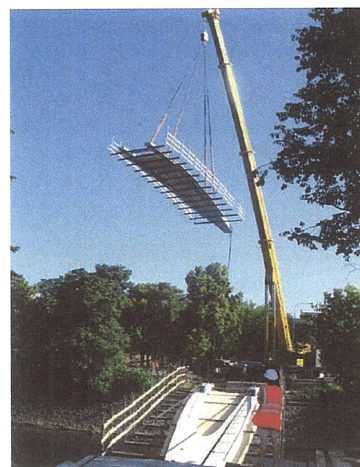
写真－5.20 アーチ部材の設置 5-10)
