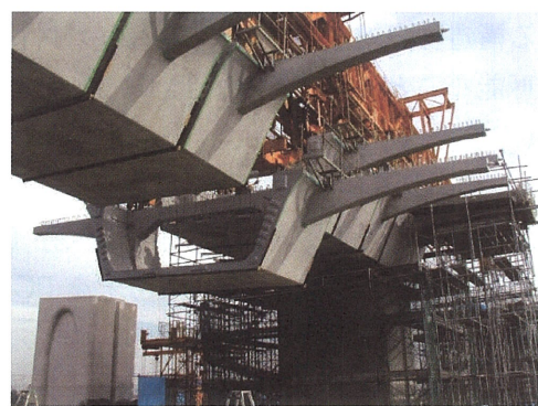
写真-3.2 プレキャストセグメント工法
