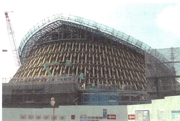
写真－5.3 施工時写真
