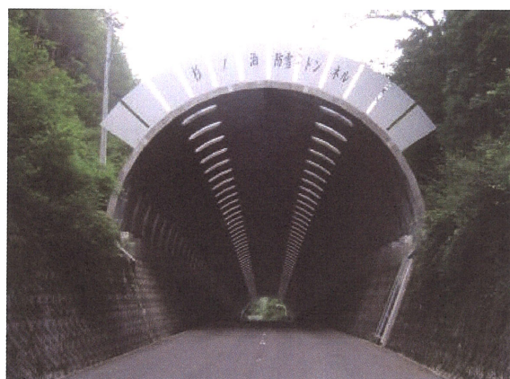
写真-5.17 スノーシェルター
