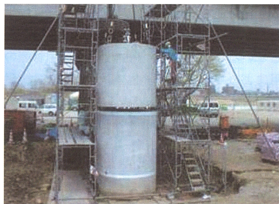
写真－5.10 プレキャスト橋脚
