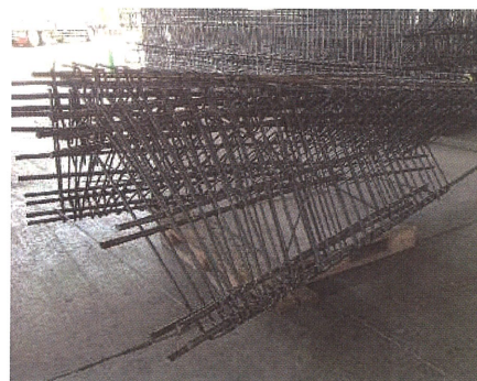
写真-2.2 柱脚部材配筋状況
