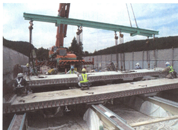
写真－5.9 鋼橋の床版取替え工事
