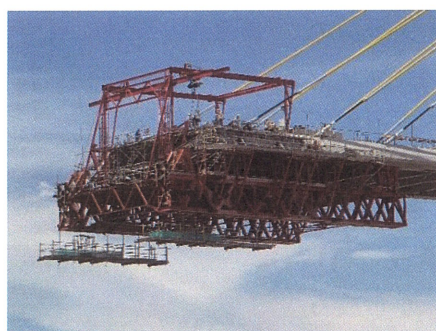
写真-3.2 下支え式移動作業車
