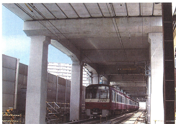
写真-5.7 京急蒲田駅付近連続立体事業
