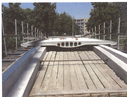
写真－5.21 床版の設置 5-10)
