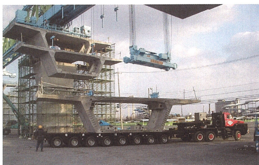
写真－4.3 フルプレキャスト箱桁断面
