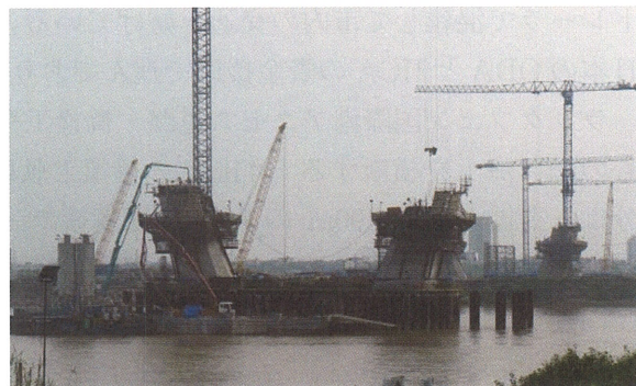
写真-1.8 施工中のニャットン橋 (2011年)
