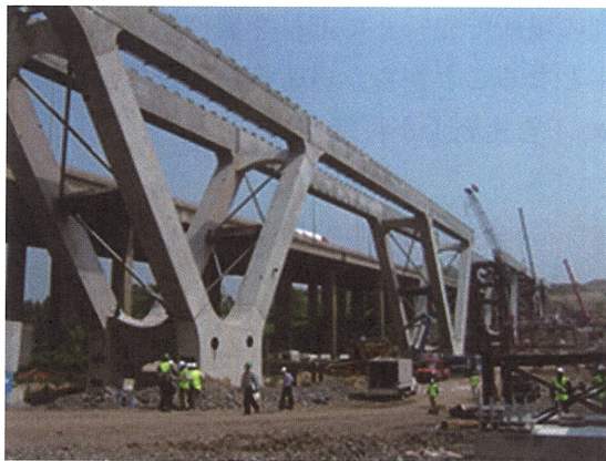
写真-5.22 施工状況
