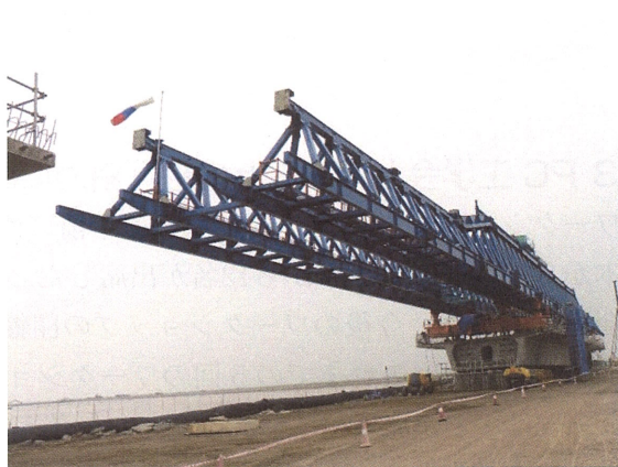
写真-1.5 セグメントの架設状況
