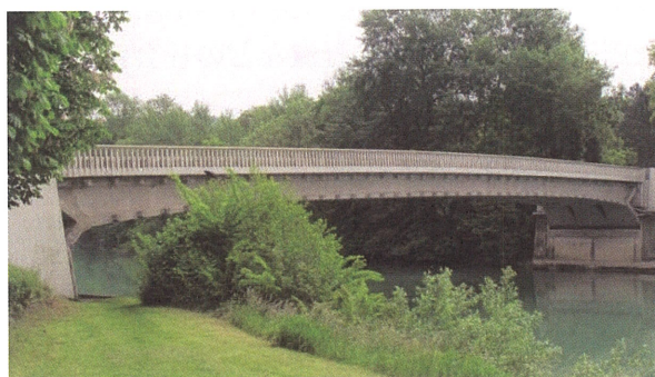
写真－3.5 現在の Luzancy 橋
