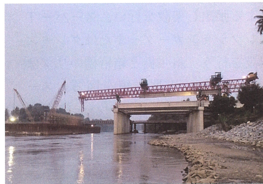
写真-3.11 桁を後ろから送り込む架設
