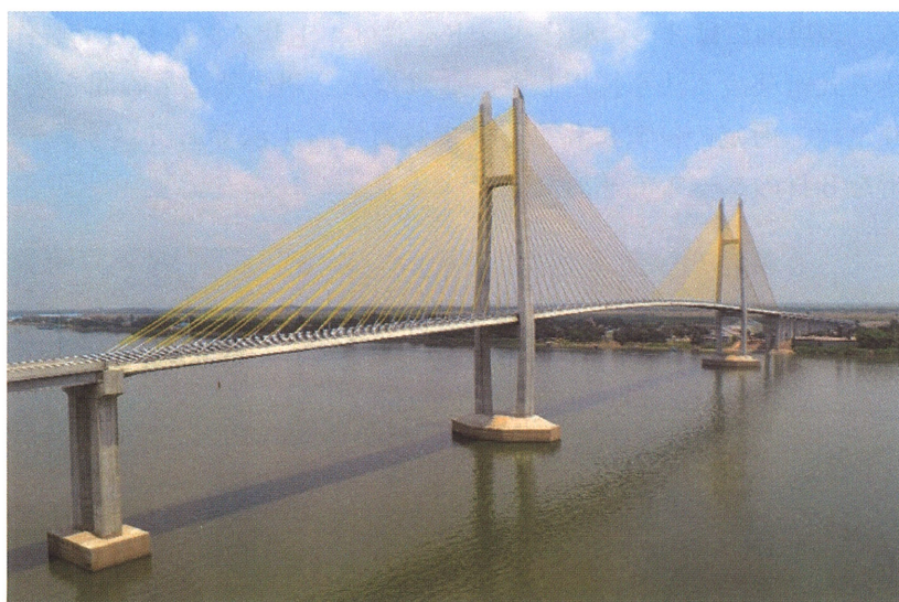
写真－3.1 完成写真
