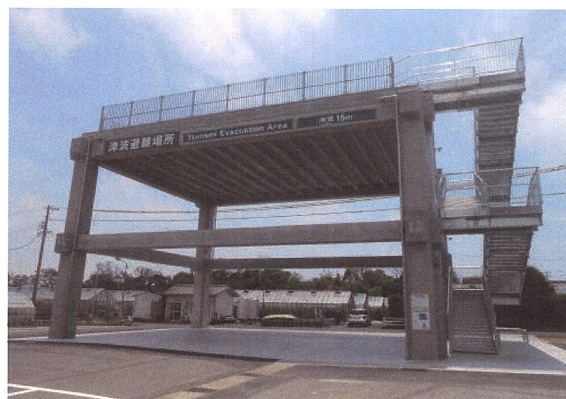
写真-5.18 津波避難人工地盤
