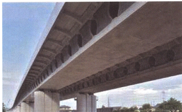
写真-5.6 桶川第2高架橋
