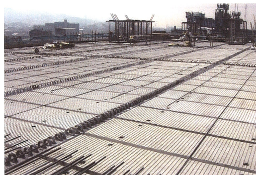
写真－4.2 箱桁上床版に配置したPC板
