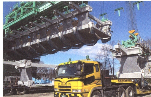
写真－4.4 部分プレキャスト箱桁断面
