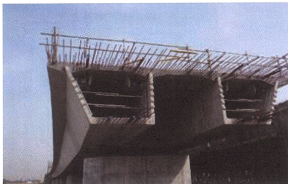
写真-5.5 中新田高架橋
