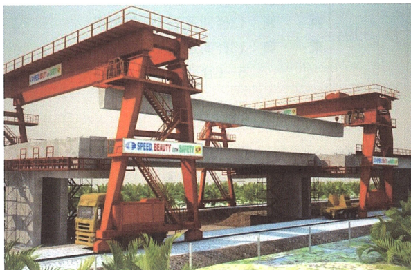
図-3.9 門型クレーンによる桁架設
