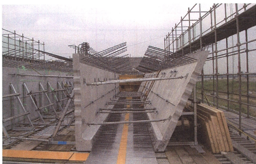
写真－4.1 プレキャストウェブ構造
