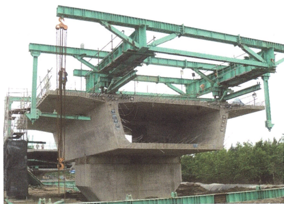
写真-1.6 片持ち張出し架設の状況
