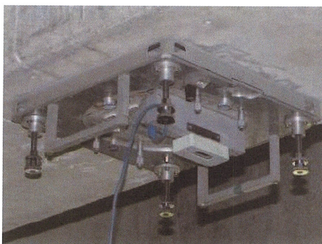
写真-2.2.1 全視野ひずみの測定 （切削前後）
