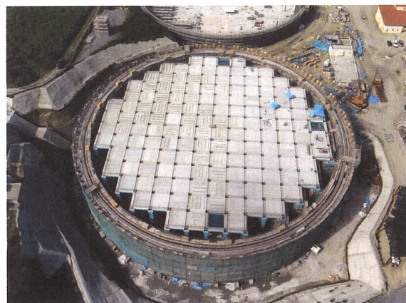
写真-5.14 PCタンク
