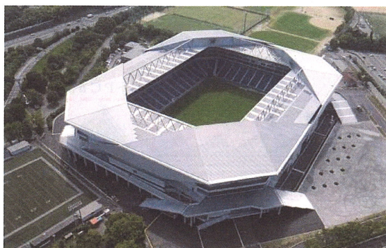
写真-3.1 完成写真
