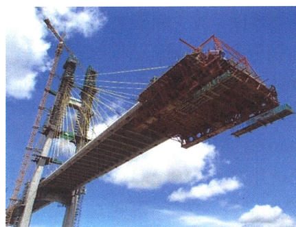
写真-3.3 張出し架設状況
