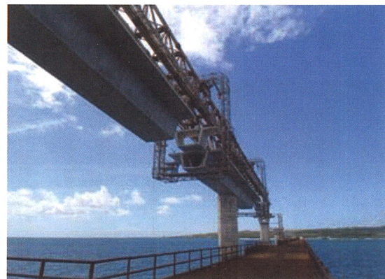
写真-5.4 伊良部大橋架設状況
