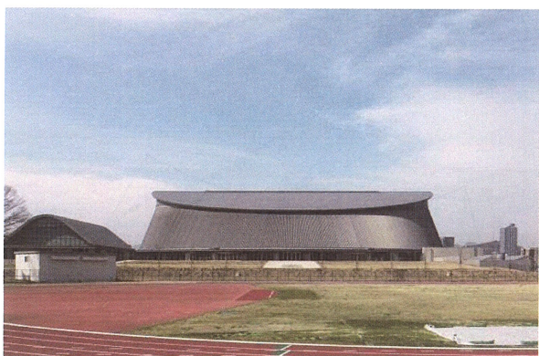
写真－5.1 建物外観写真 1)
