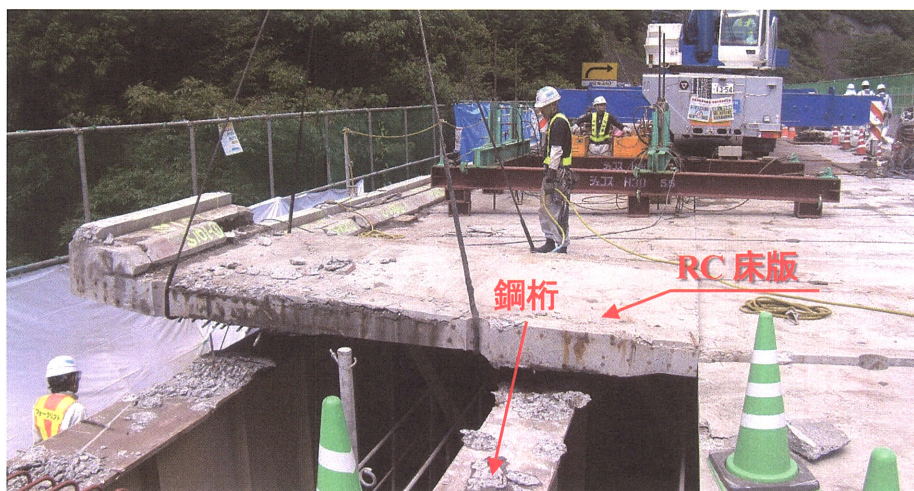
写真－1 鋼橋 RC 床版の更新工事における既設 RC 床版の撤去事例
