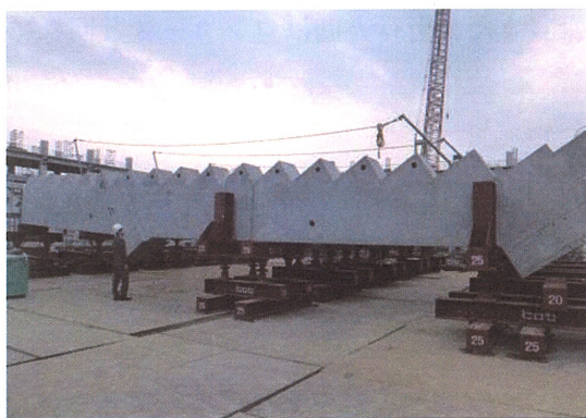
(a) 地組状況（一般部）
