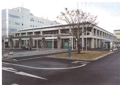
写真-3.3 山梨市庁舎
