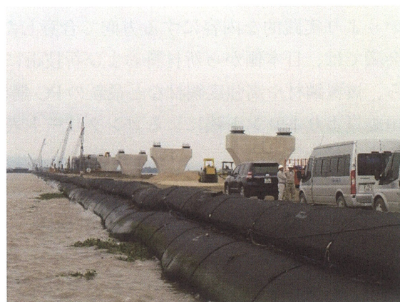
写真-1.7 盛土補強用ジオチューブ
