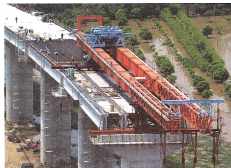
写真-3.5 PCI 桁架設状況
