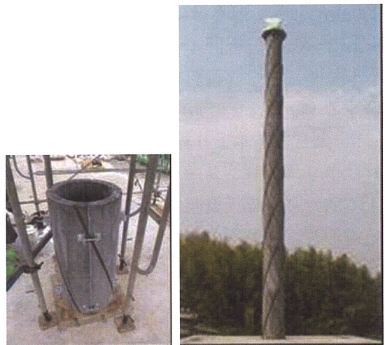
写真-6.2 8m タワーの施工状況と完成状態
