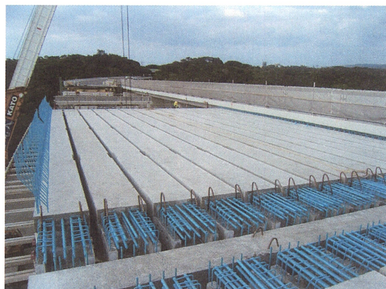
写真－5.8 億首川橋架設状況
