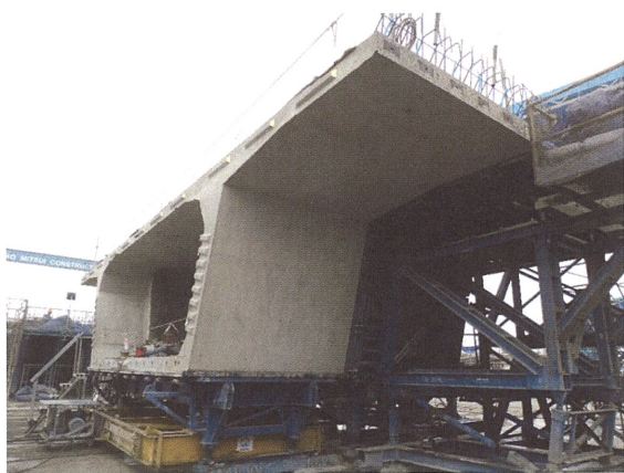
写真-1.4 セグメントの製作状況
