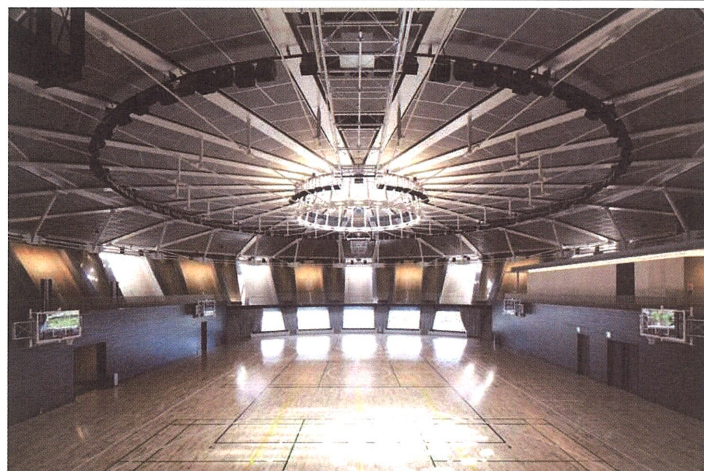
写真-4.1 フォーラム棟内観 (屋根架構はテンション材と鉄骨梁を組み合わせたフープ式張弦梁を採用)
