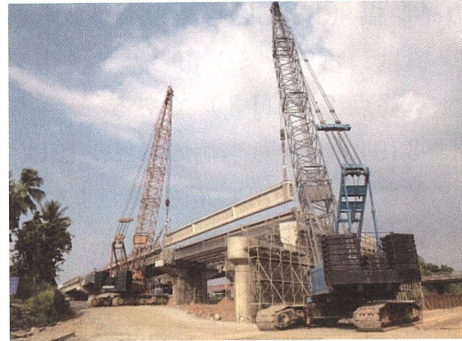
写真-3.9 タンデムクレーンによる相吊り
