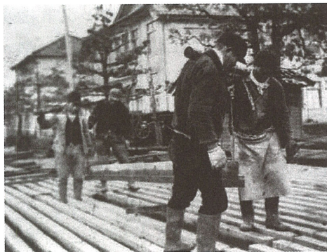
写真-3.7 長生橋の架設状況 3-3)
