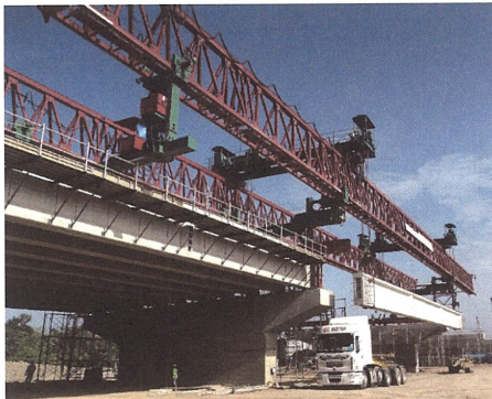
写真-3.10 桁を横から送り込む架設
