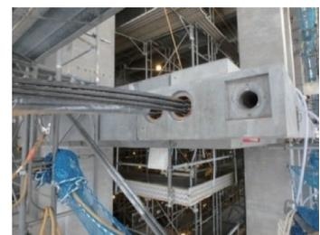
写真-5.5 化粧リブと調整ケーブル除荷後状況
