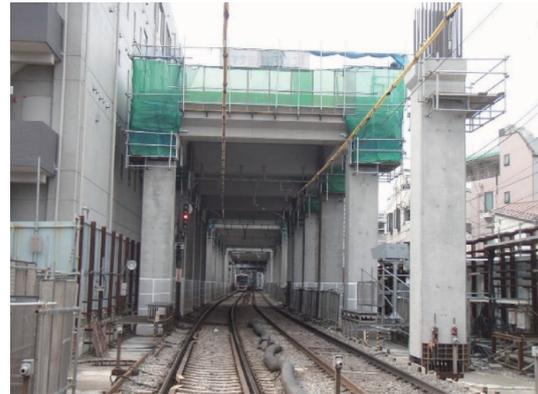
写真-4.8 営業線直上の高架橋の施工
