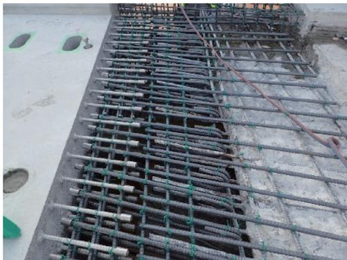
写真-8 接合部鉄筋の配置
