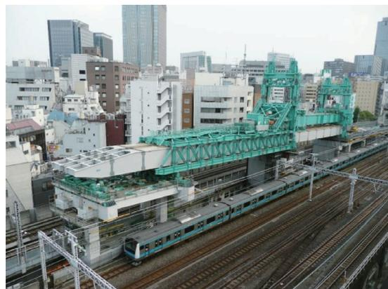
写真-4.2 上野東京ライン PC 箱桁架設状況
