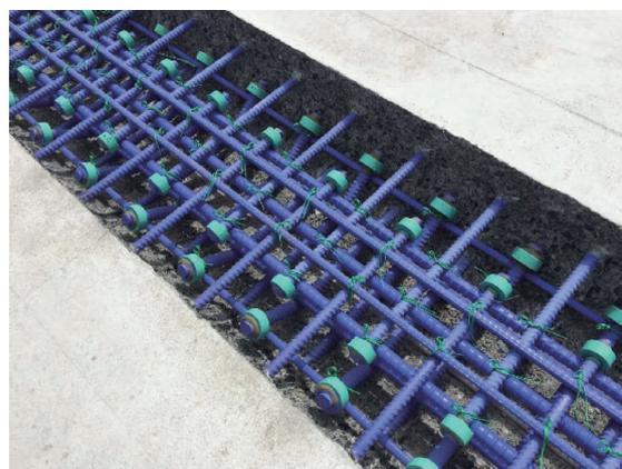
写真-12 継手構造
