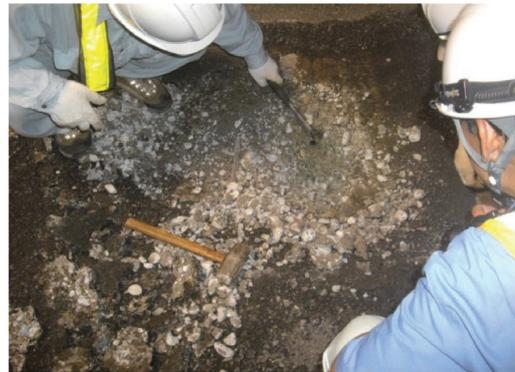
(b) 鉄筋が露出するまで工具で掘れる状態
