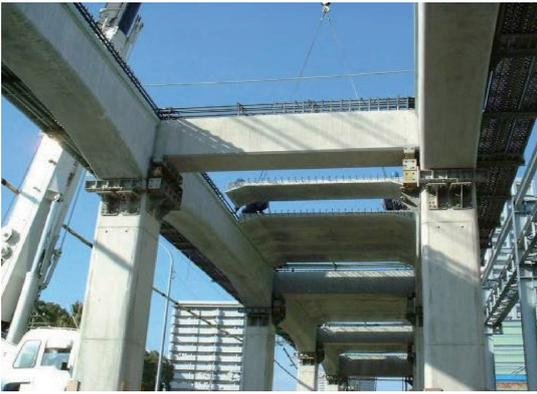
写真-4.7 PCa 梁・スラブの施工
