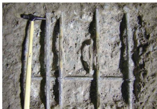
写真-2.2 RC床版上面の鉄筋の腐食事例(車輪走行位置付近の路面の舗装、かぶりを除去した状態)<sup>1)</sup>、<sup>4)</sup>
