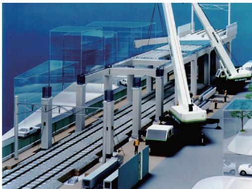
図-4.6 HPCa 工法の概念図
