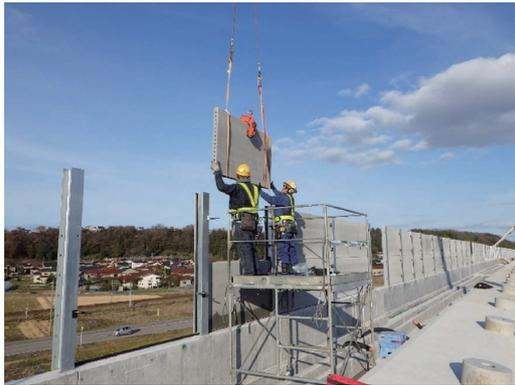
写真-2.9 防音壁のPCパネルの設置状況
