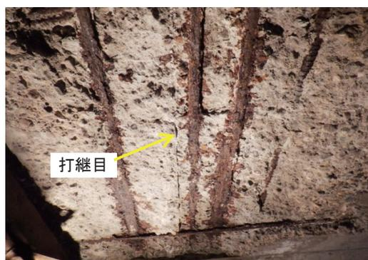
写真-2.3 打継目付近におけるRC床版下面の鉄筋の腐食(床版下面のかぶりを除去した状態)<sup>1)</sup>
