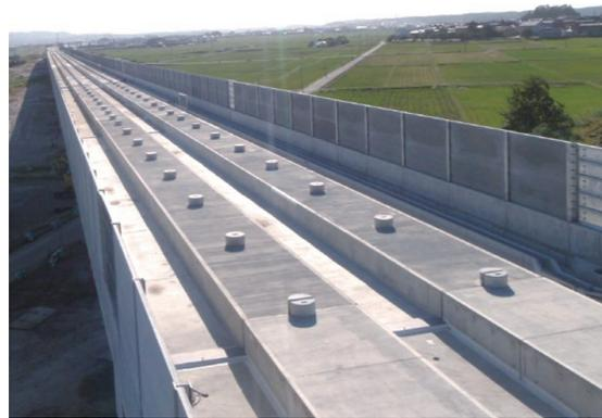
写真-2.10 設置後のパネル式防音壁
