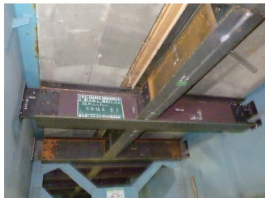
写真-4 仮設縦桁・仮設横桁の設置
