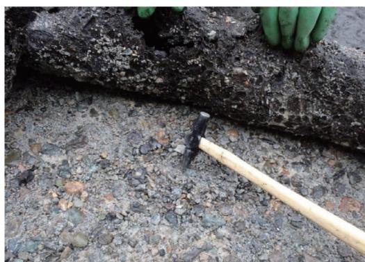
写真-3.3 防水層下の土砂化の事例<sup>6)</sup>
