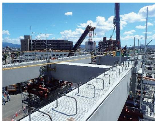
写真-4.12 施工しやすい梁スラブ接合部
