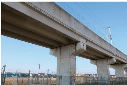
写真-4.5 完成した PCU 形桁 (つくばエクスプレス)
