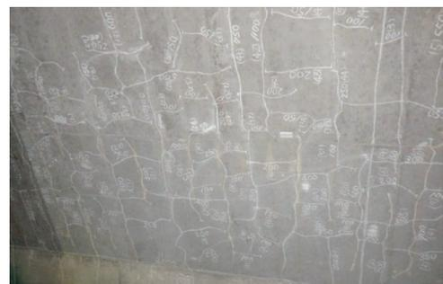
(a) 床版下面の格子状のひび割れ
