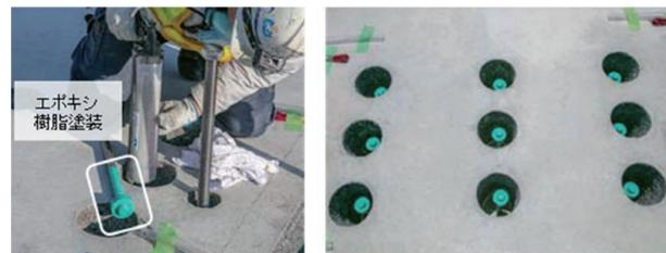
写真-11 ずれ止め鉄筋
