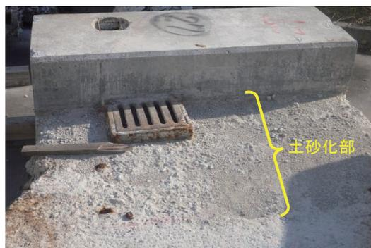
写真-3.2 地覆、排水口付近の土砂化の事例<sup>6)</sup>
