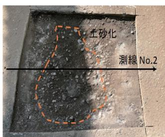
写真-5.5 舗装開削 (土砂化部)
