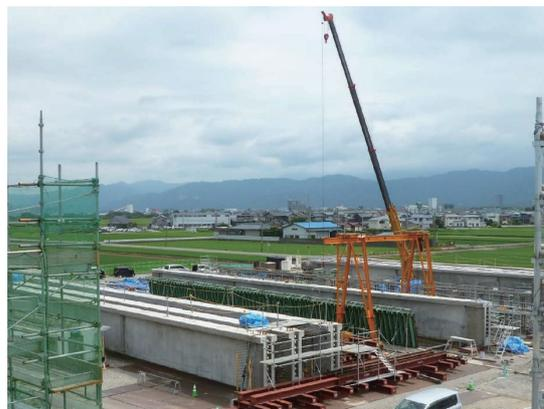
写真-4.3 現場ヤードでの PCT 形桁製作状況
