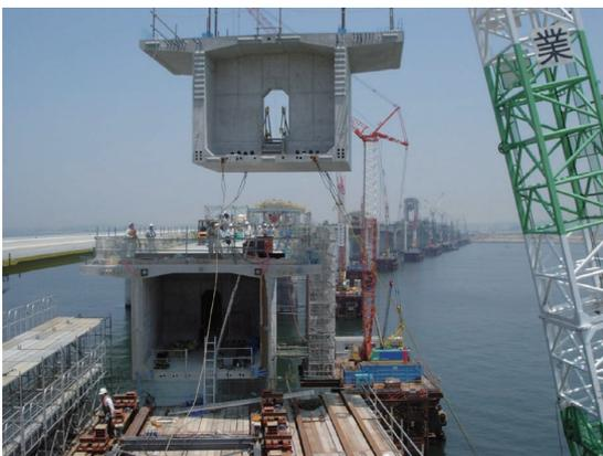
写真-4.1 中部国際空港線のPCa セグメント桁架設状況
