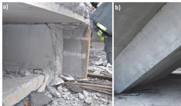
写真-1.6 破壊した接合部と崩壊後の橋梁の外観
