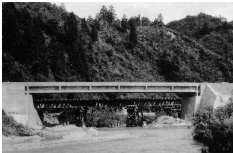
写真-5 桁の設置状況 (FKK 提供)
