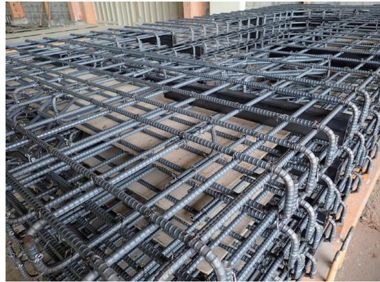
写真-4.14 完成した枠型スラブ配筋
