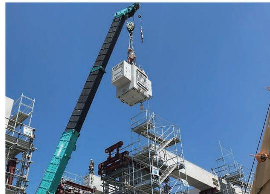
写真-4.9 PCa化された梁・柱接合部
