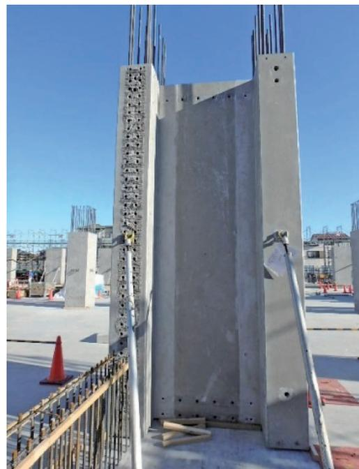
写真-5.2 H 型柱建て方状況
