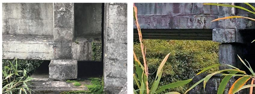
写真-3 仏式ロッカー支承(左:固定、右:可動)
