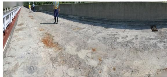
写真-5.1 土砂化が進行した事例
