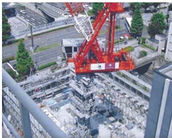
写真-4.4 タワークレーン設置状況
