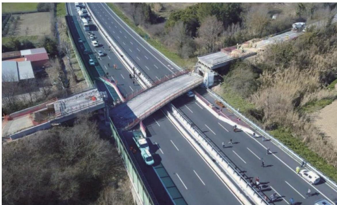
写真-1.4 崩壊直後のアンコーナ跨道橋
