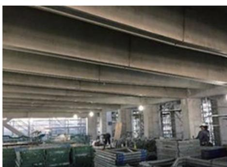
写真-4.6 PCa 部材の架設状況
