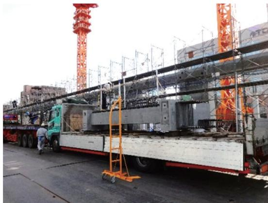
写真-5.4 スパン梁製品検査状況
