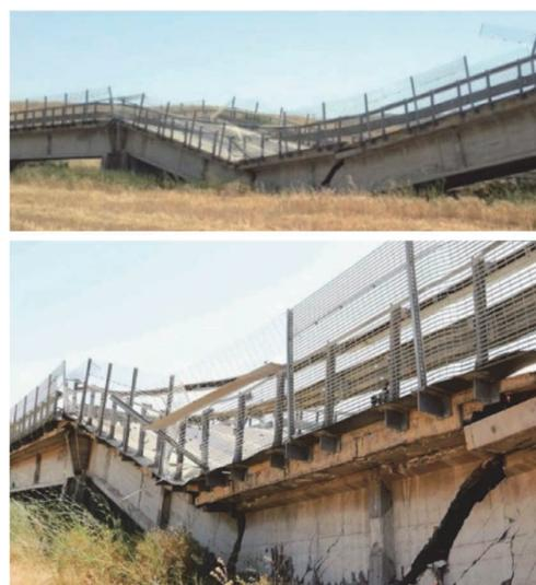
写真-1.1 崩壊したペトルッラ高架橋
