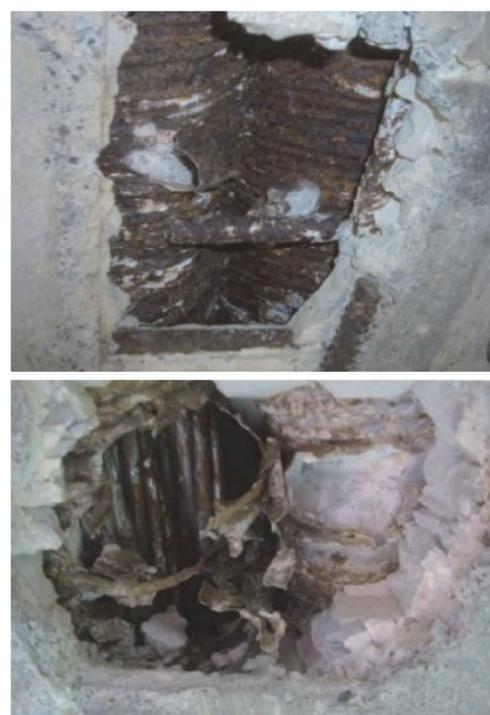
写真-1.2 腐食した PC 鋼材と鋼製シース
