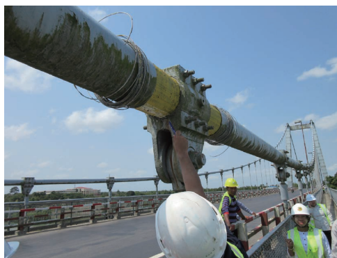
写真－1.3 橋梁調査（ミャンマー）
