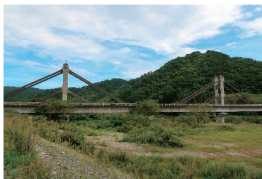
写真-2.9 小本川橋梁
