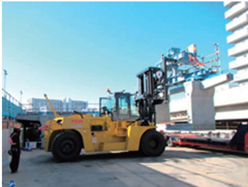
写真-3.2.2 フォークリフトでの吊上げ
