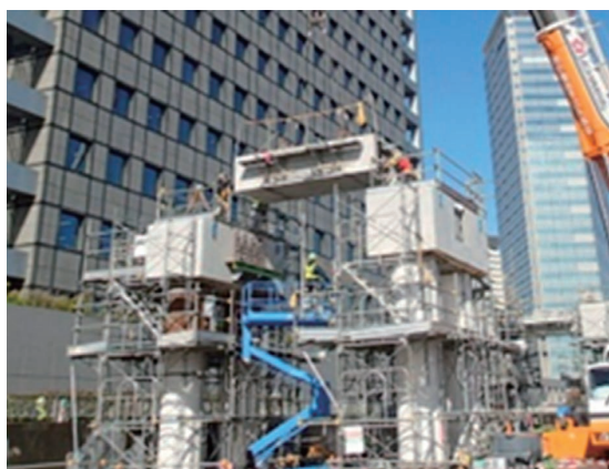
写真-3.1.1 横梁ブロック架設状況
