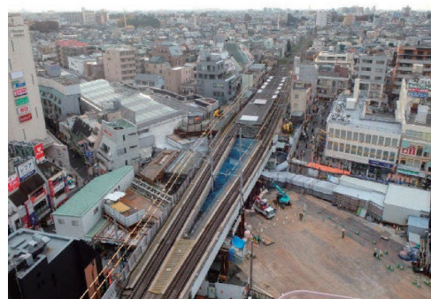
写真-4.1 工事地点概要
