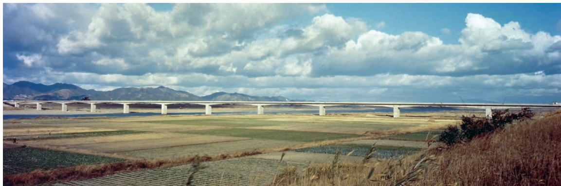
写真－2 1959－1963年にディビダーク工法で建設された名田橋（徳島県）
