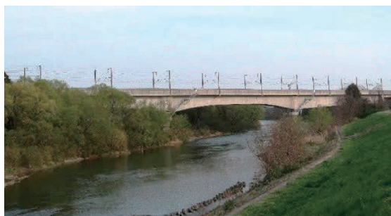
写真-2.7 第二阿武隈川橋梁
