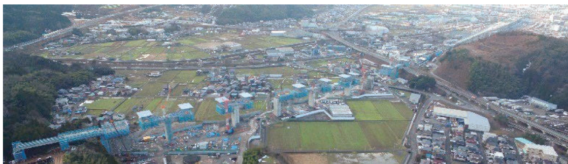
写真-3.9 建設中の大蔵余座高架橋と敦賀バイパス架道橋
