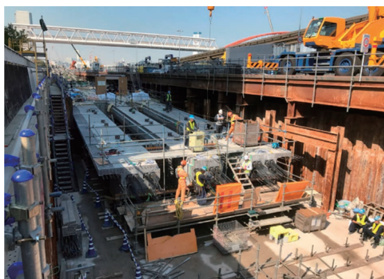
写真-3.1.3 部材の引き寄せ状況
