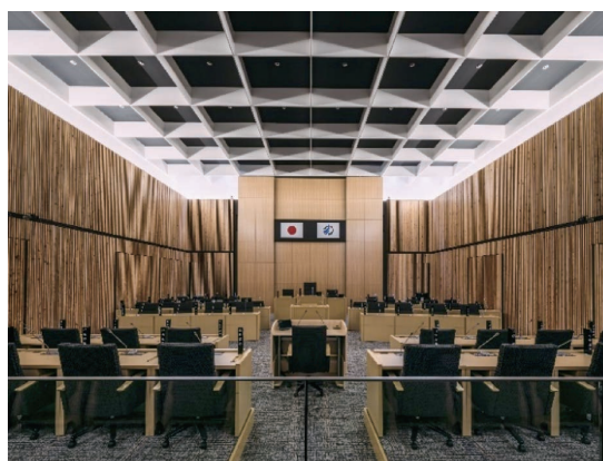
写真-5.3 鉄骨格子フレームの議場屋根
