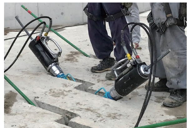
写真－4.7 緊張作業の状況
