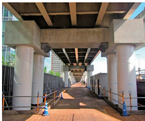
写真-3.1.2 う回路高架部完成状況
