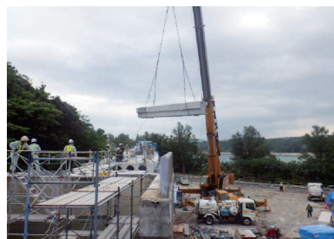
写真-7 RC 中空床版橋の撤去状況
