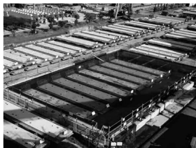
写真-4.2 プレキャストPC床版の水中養生
