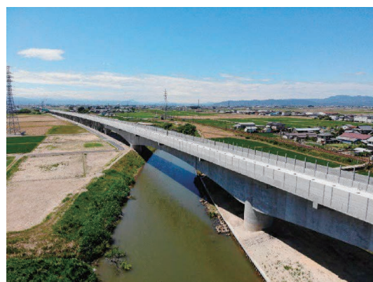
写真－3.5 第2竹田川橋梁
