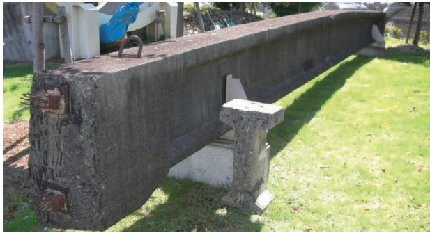
写真-2.2 東京駅ホーム桁（撤去後）
