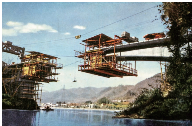
写真-11 片持ち張出し架設中の嵐山橋
