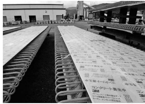
写真-4.4 保水養生テープを用いた封緘養生
