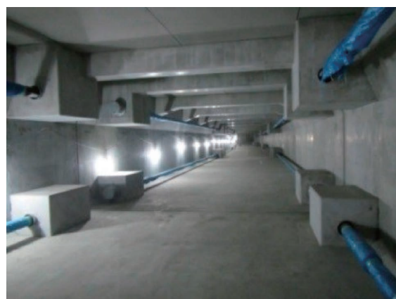
写真-3.2.1 縦断方向PC連結
