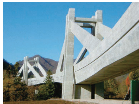
写真-2.12 第二吾妻川橋梁
