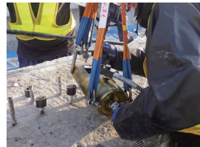
写真－2 圧着定着作業状況
