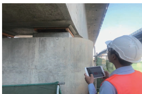
写真－1.2 タブレット端末橋梁点検（カンボジア）
