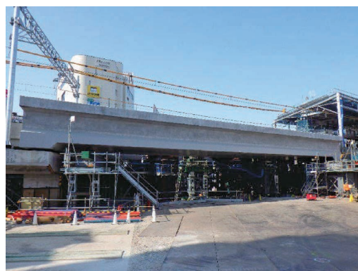
写真-4.2 架替え後の橋梁全景
