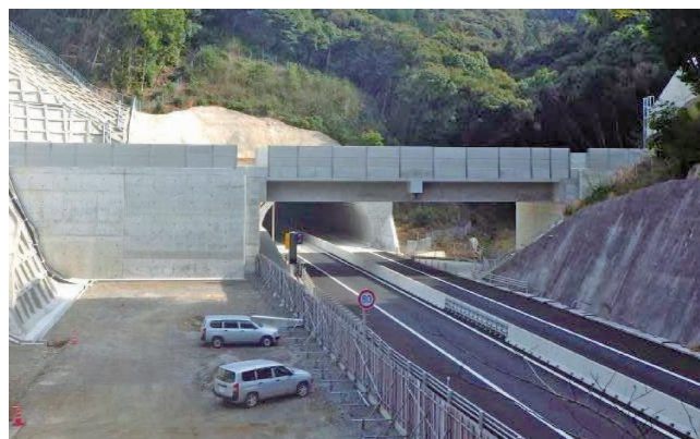
写真－3.3 原種架道橋
