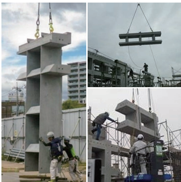
写真-3.9 フィーレンディール架構の架設状況
