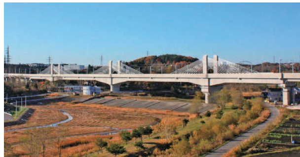
写真-2.14 三内丸山架道橋
