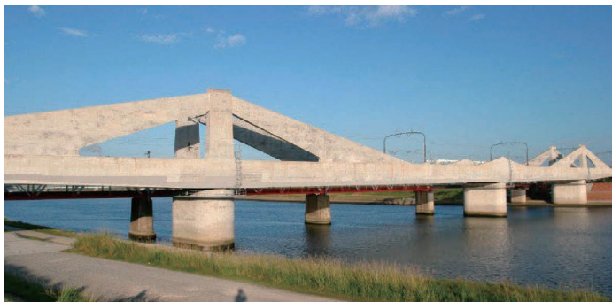
写真-2.11 川内川橋梁
