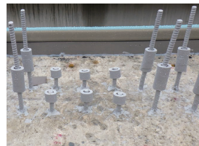
写真－3 圧着定着完了状況
