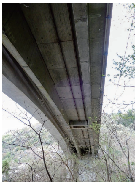
写真－13 現在の嵐山橋（桁下）
