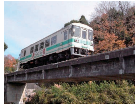
写真-2.3 第一大戸川橋梁
