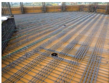
写真－5.5 アンボンドPCケーブルの配線状況
