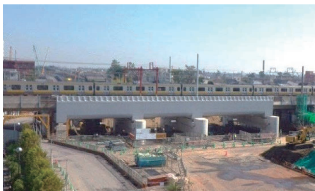
写真-4.4 受け替え・柱撤去完了後
