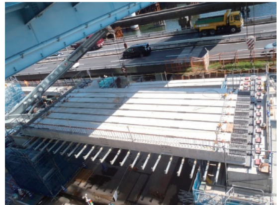
写真－3.1.5 プレテンホロー桁架設
