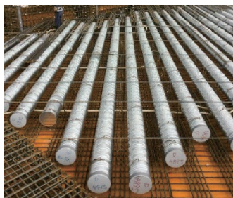
写真－5.6 鋼管ボイドの配置状況
