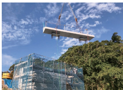
写真-8 横梁架設状況
