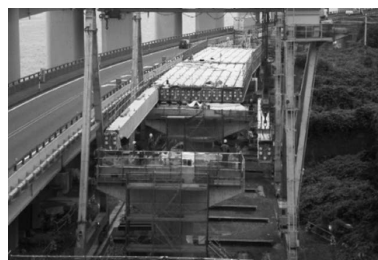
写真-4.1 架設状況
