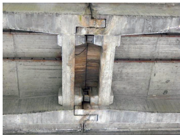
写真-6 現在の中間ヒンジ部
