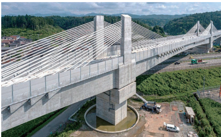
写真-3.6 完成した細坪架道橋
