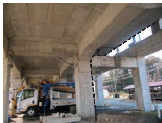
既設高架橋 | 新設高架橋 写真－4.3 新花巻駅高架橋
