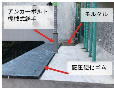
写真-10 感圧硬化ゴム敷設状況
