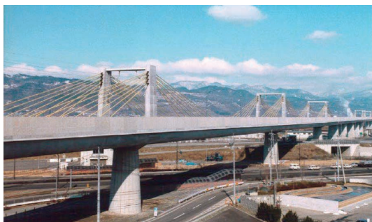
写真-2.13 屋代架道橋
