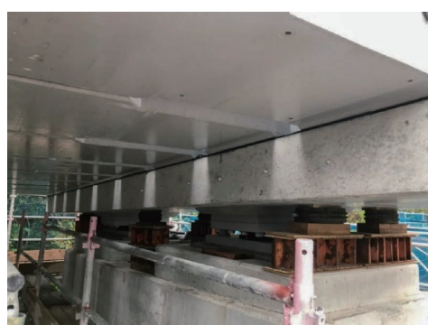
写真-9 横梁高さ調整状況
