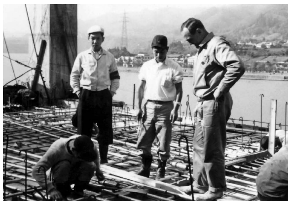
写真－10 現場で指導中のマルヘッティ職長
