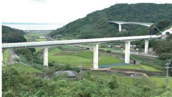
写真-3.1 完成した千綿川橋梁全景
