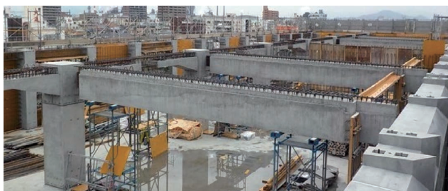
写真－3.4 端部をガセット接合とした PCaPC 大梁
