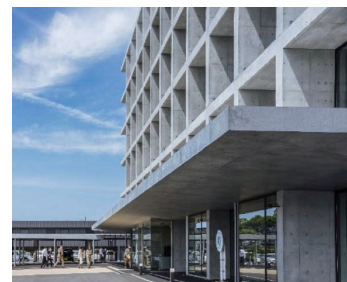
写真－5.7 エントランス側大庇
