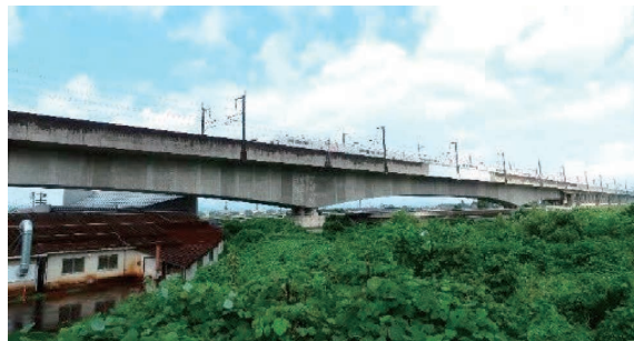
写真-2.8 太田川橋梁
