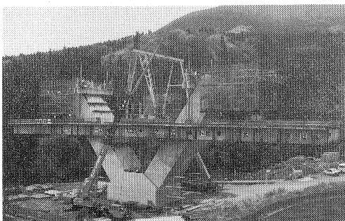
リフトアップ状況
