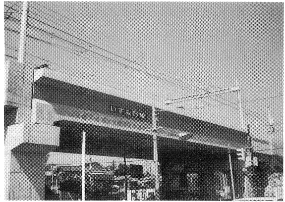
写真 - 1 橋梁完成写真
