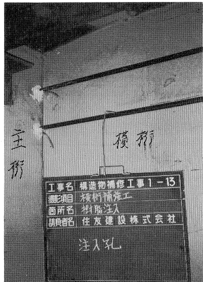
写真-2 主桁部への注入
