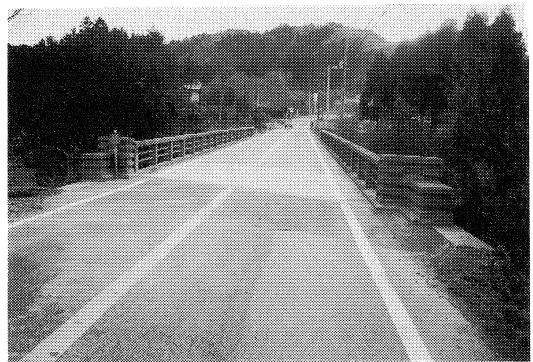
写真-1 撤去前全景
