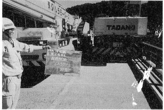
写真-2 実橋載荷試験
