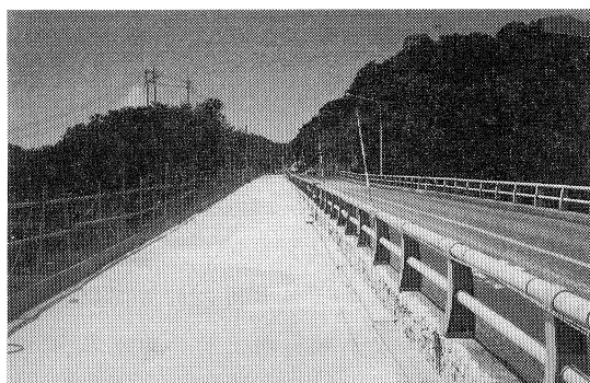
写真-3 新設橋と既設橋の橋面
