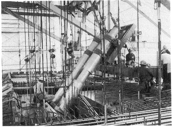
写真-3 主桁側斜材定着体据付け状況
