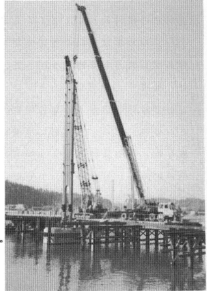
写真-3 タワー架設
