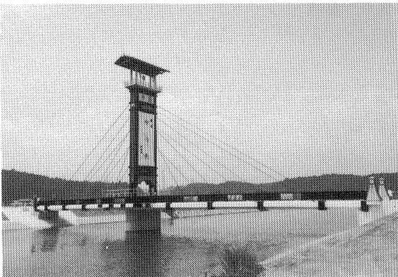
写真-1 左岸より完成写真
