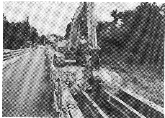
写真-6 床版撤去
