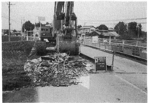
写真-1 PC床版撤去状況
