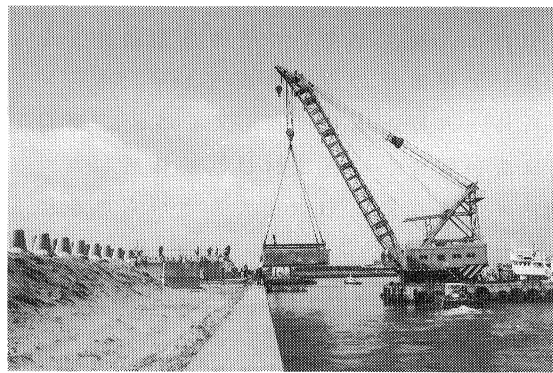
写真-2 浮体吊降し工
