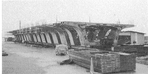
写真-3 主桁ストック状況
