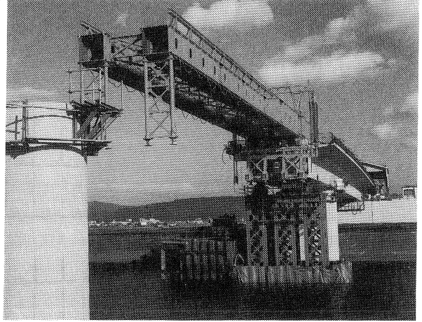
写真-2 仮支柱全景
