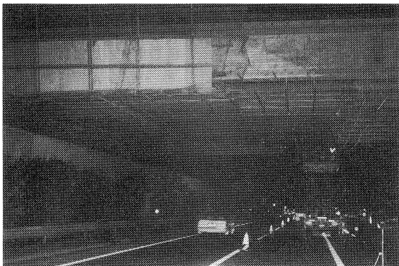
写真-3 吊足場施工
