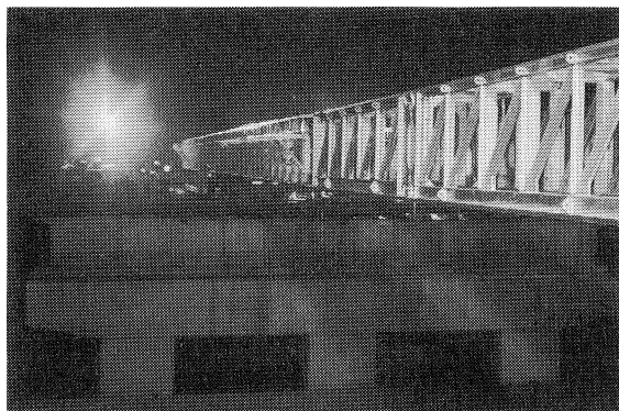
写真-1 架設桁の引出し
