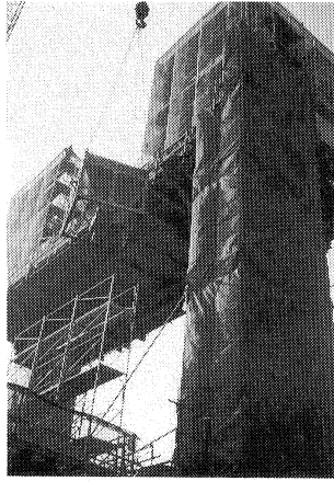
写真-2 吊上げ状況
