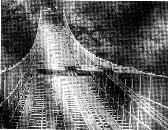
写真-2 プレキャスト版の架設
