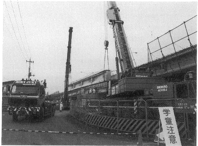
写真-1 主桁架設状況
