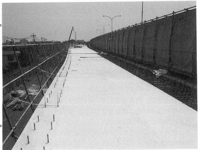
写真-3 PC単純合成桁1次床版施工状況
