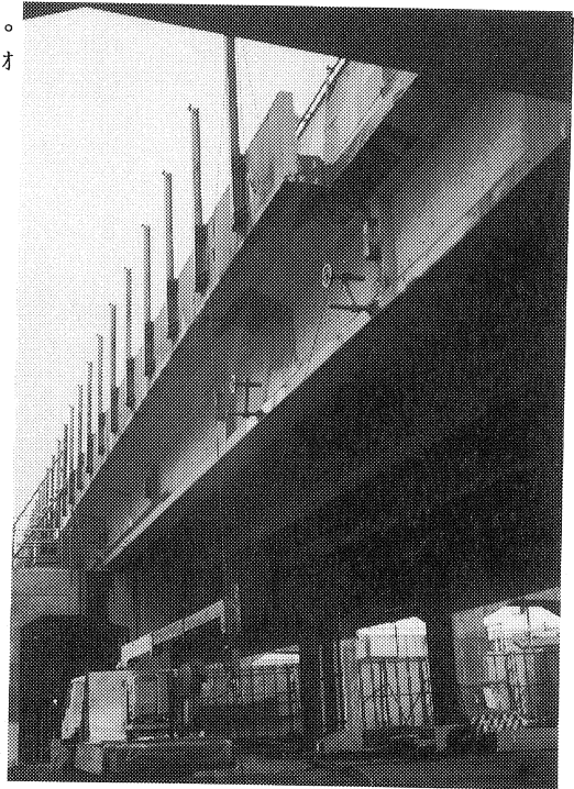
写真-2 既設床版・高欄撤去状況
