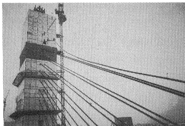
写真-5 PE管吊上げ
